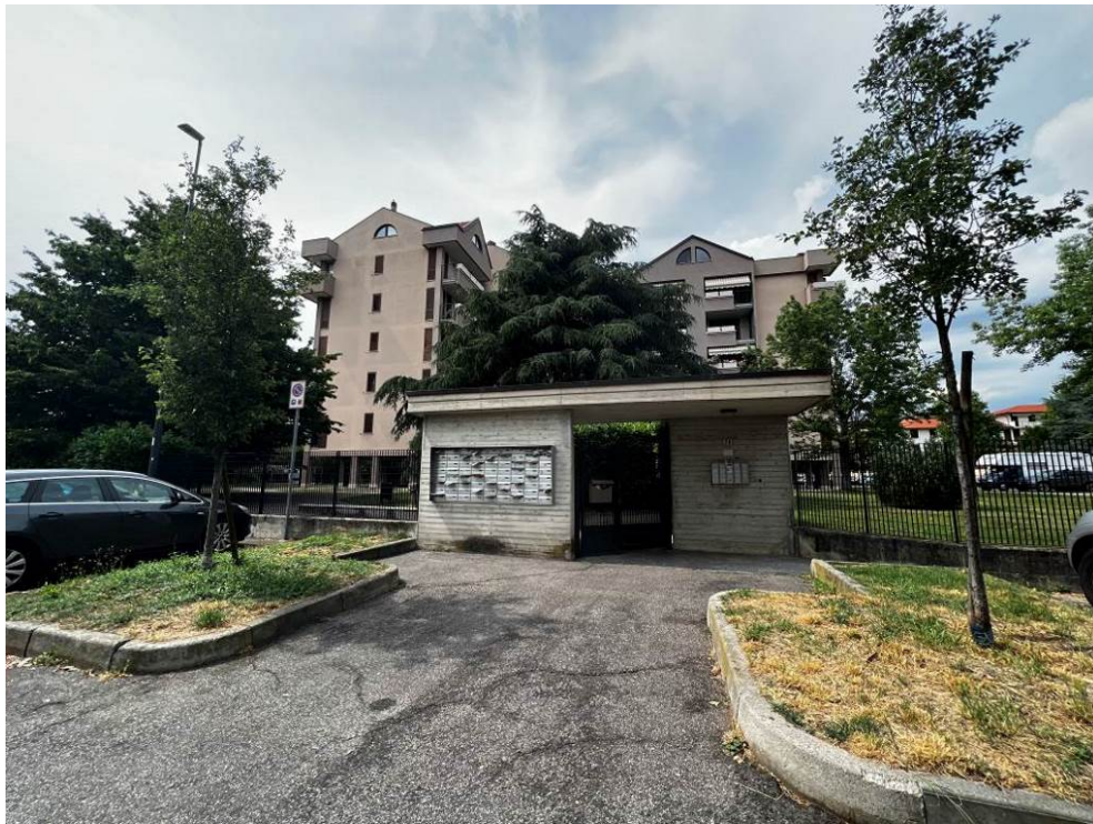
Fotografia n. 1 – Vista dell'ingresso pedonale al complesso immobiliare ad uso residenziale denominato "RESIDENZA AL PARCO"
