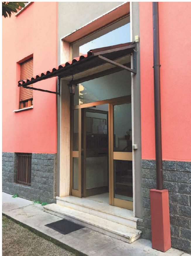
Foto 05 - Accesso al fabbricato dal cortile comune
