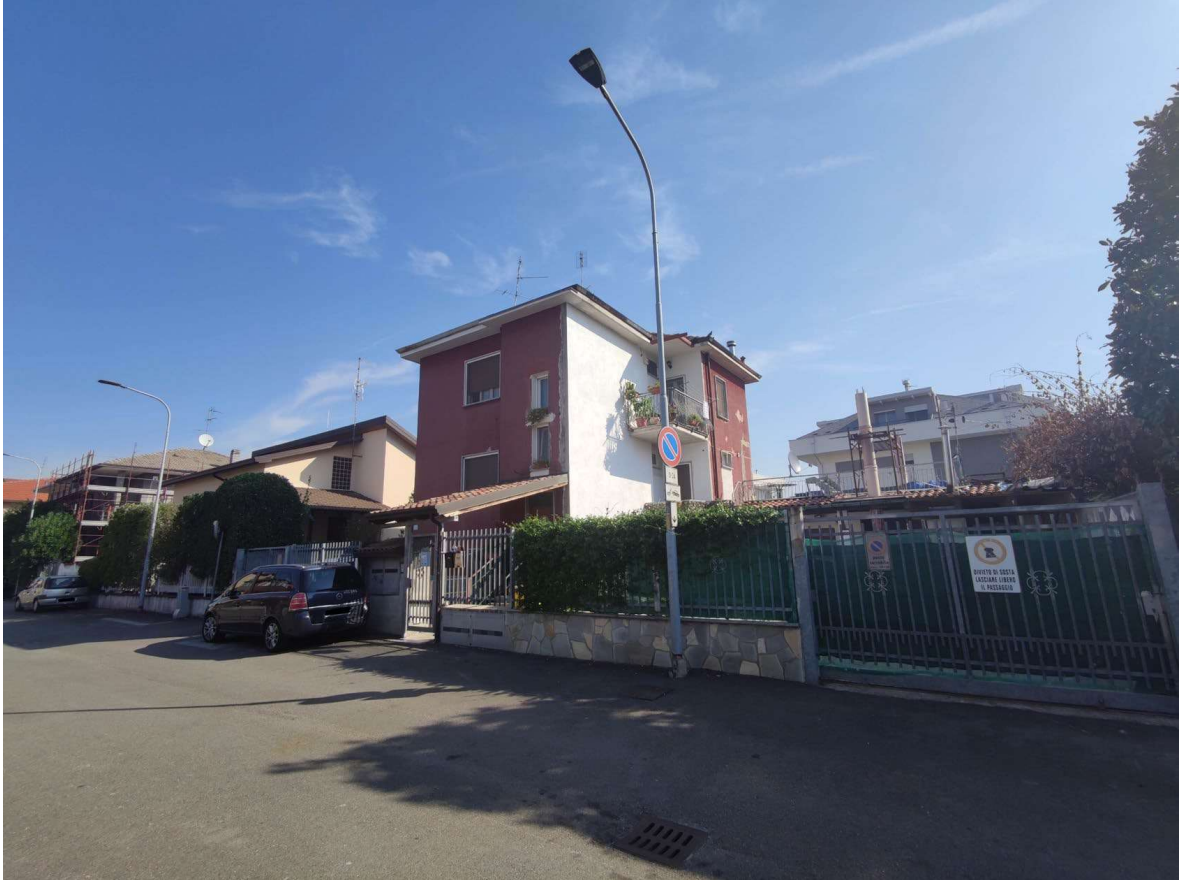
Immagine. 3. Vista da strada
