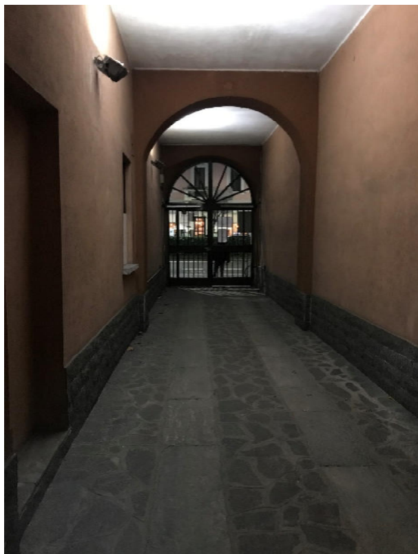
Foto n. 3: cancello ed androne comune di ingresso.
