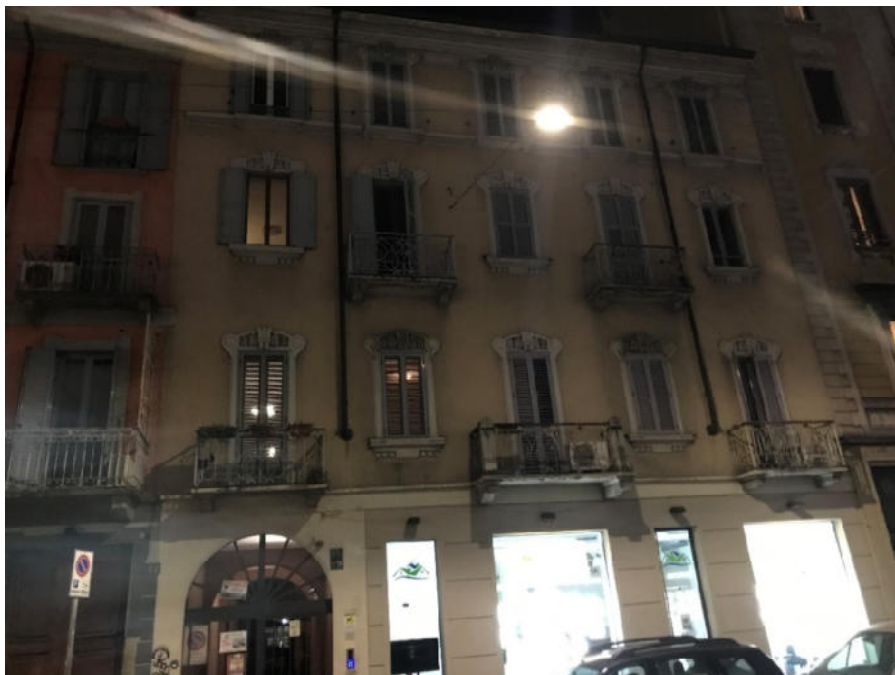
Foto n. 1: Prospetto principale su Viale Monza.
