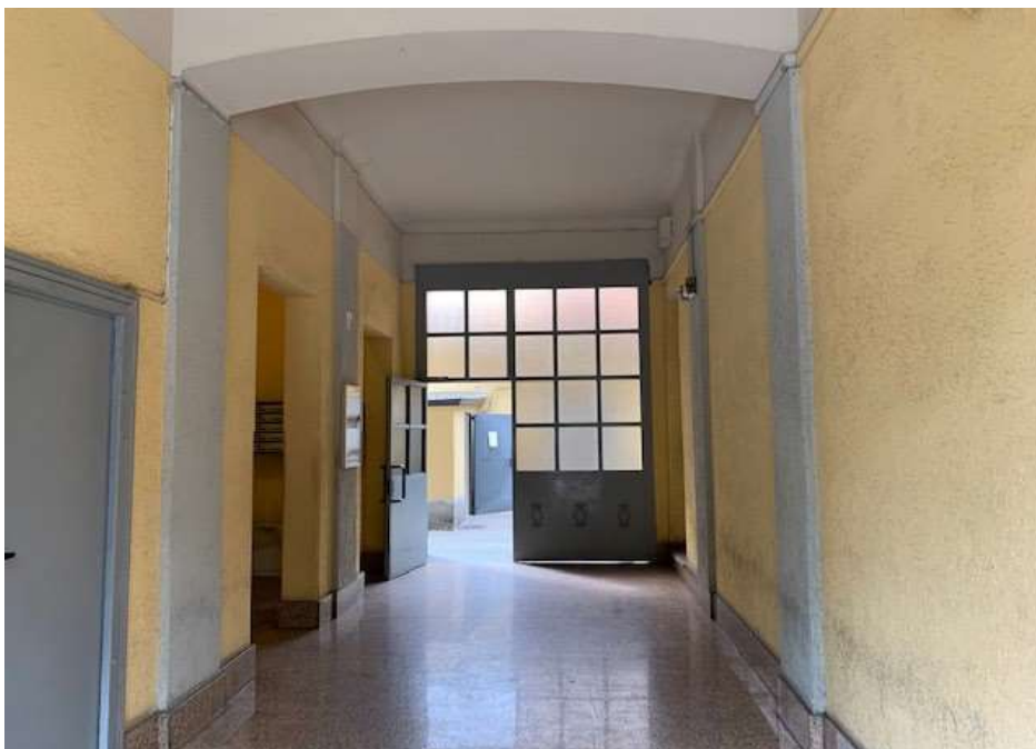
Vista interna - ingresso condominio
