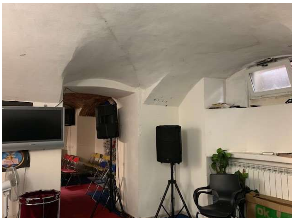
Vista interna - deposito
