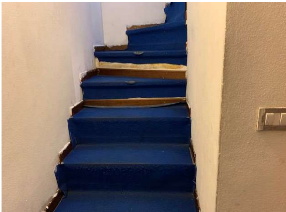
Vista interna - scala di collegamento al piano interrato
