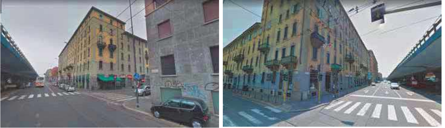
Vista esterna condominio
