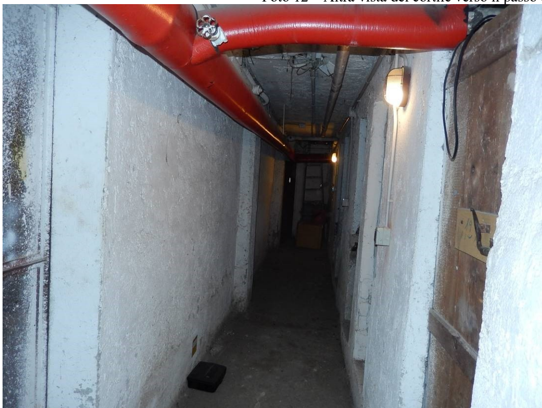
Foto 13 – Il corridoio comune delle cantine.
