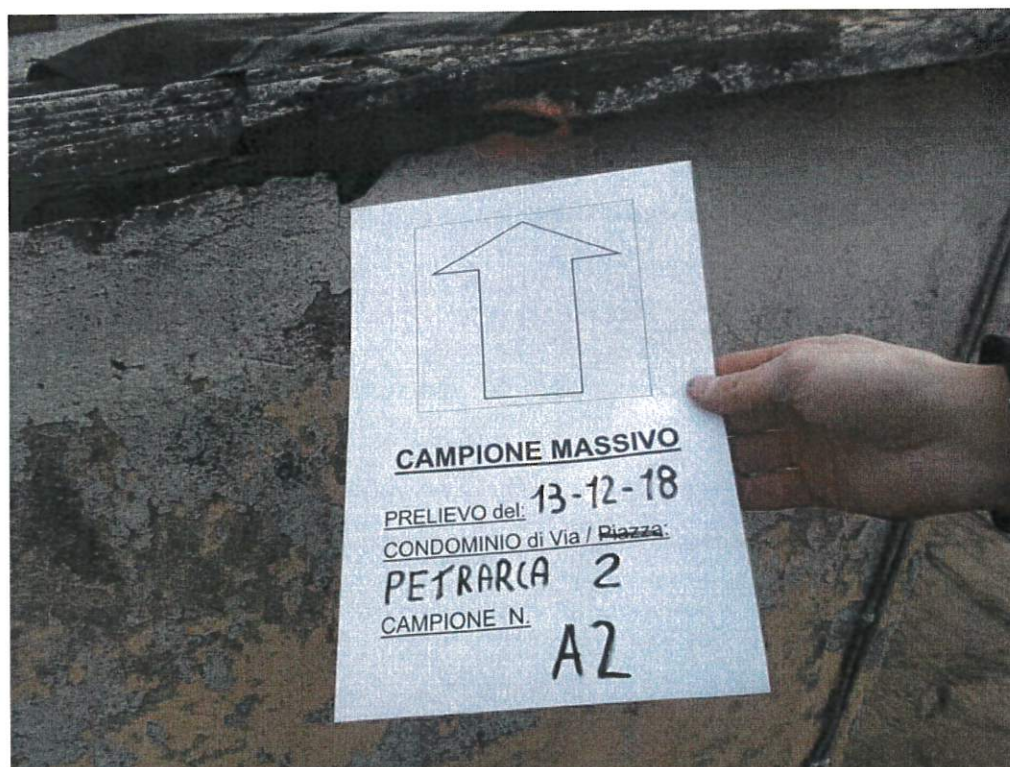
Foto 18: particolare del punto di prelievo del manto di copertura Fabbricato B
