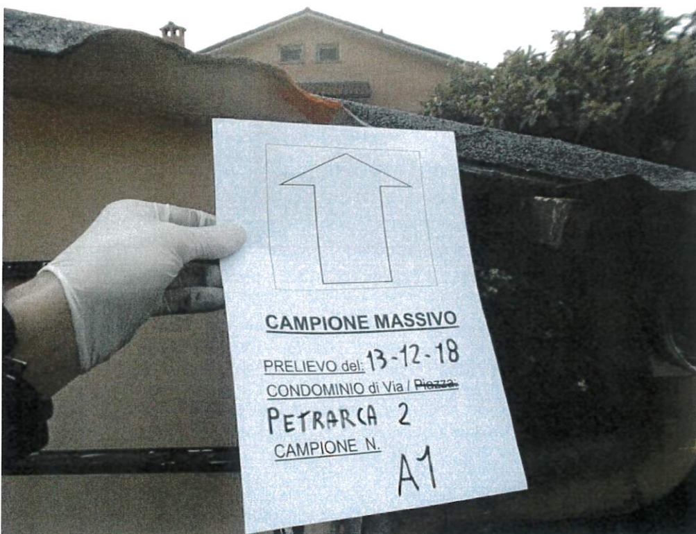
Foto 12: particolare del punto di prelievo del manto di copertura - Fabbricato A
