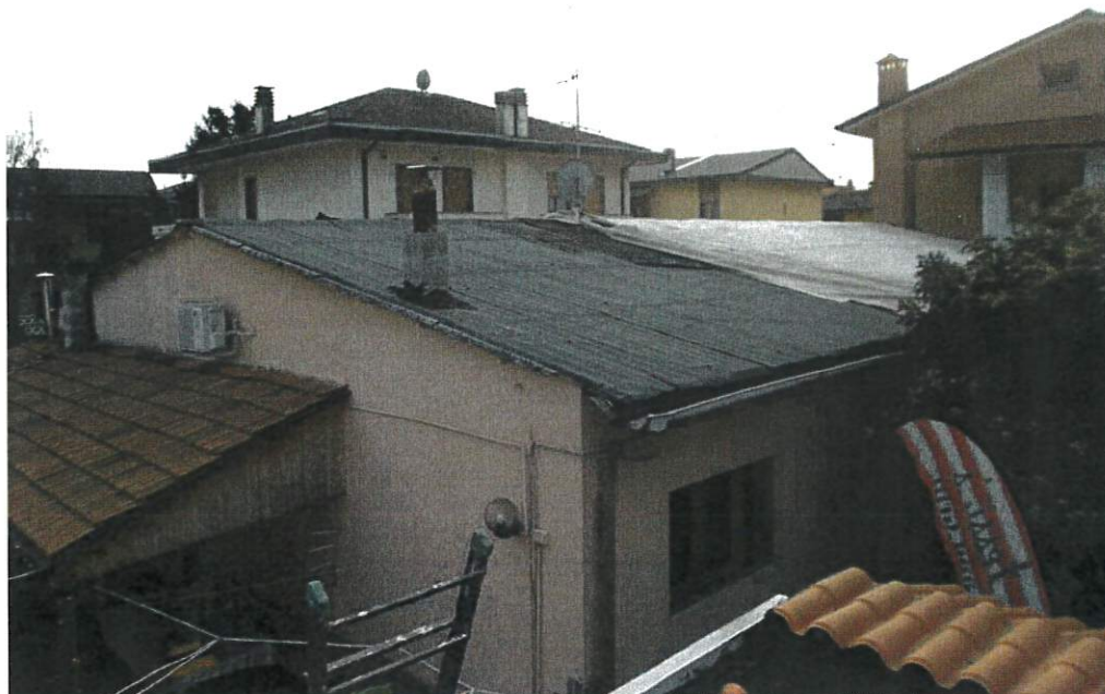
Foto 01: Manto di copertura esterno - Fabbricato A
