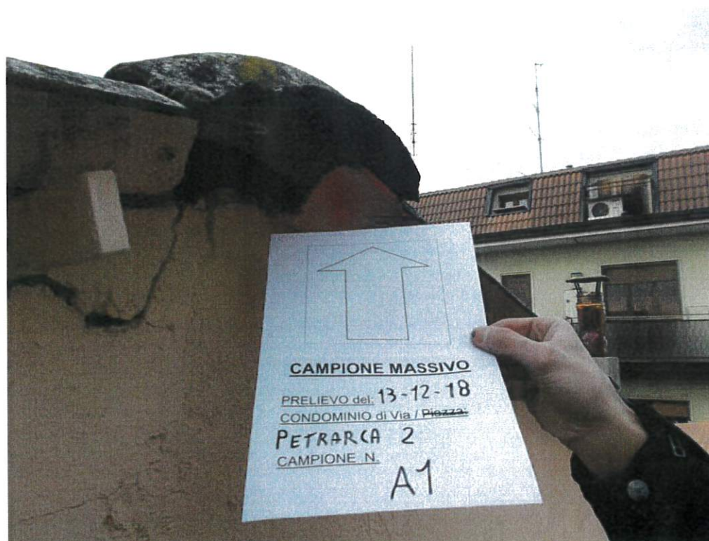
Foto 10: particolare del punto di prelievo del manto di copertura - Fabbricato A
