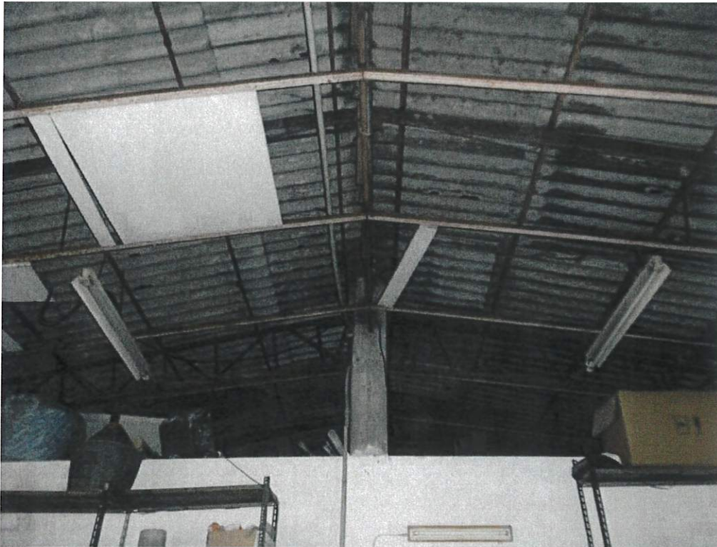
Foto 07: Manto di copertura interno - Fabbricato A
