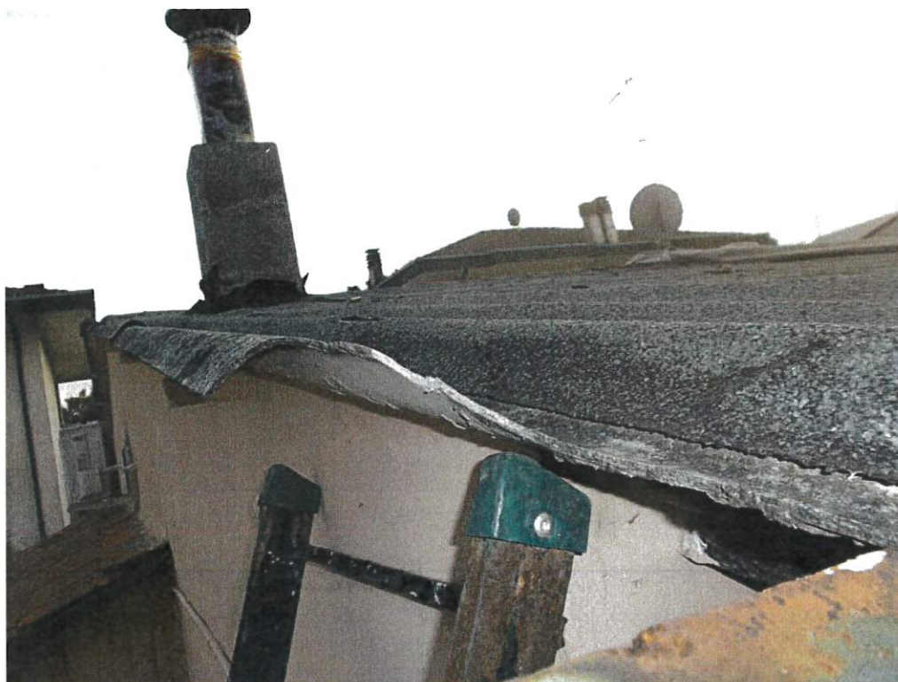
Foto 05: particolare del manto di copertura - Fabbricato A
