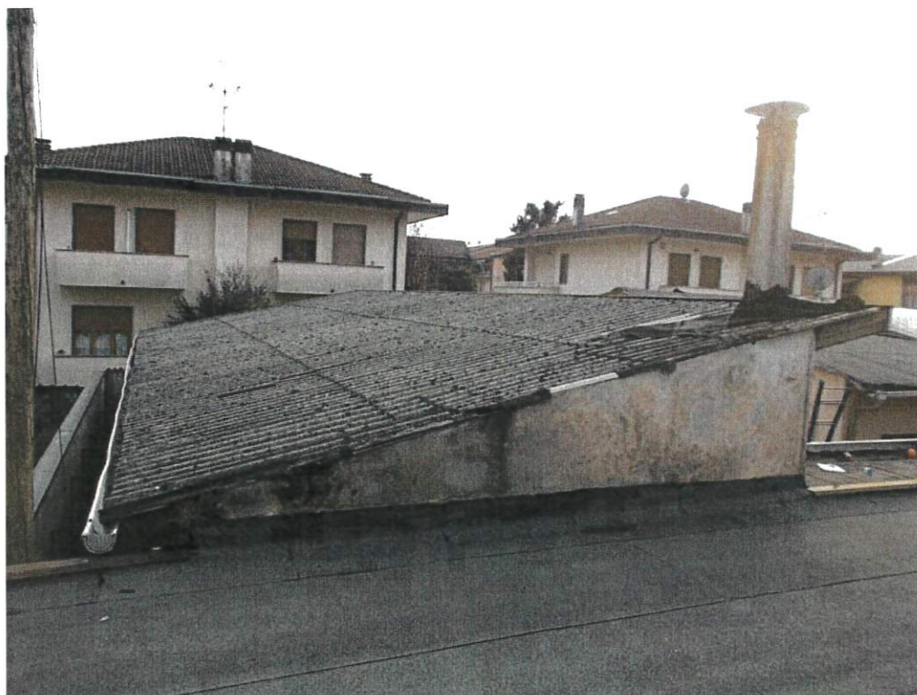
Foto 14: Manto di copertura esterno - Fabbricato B
