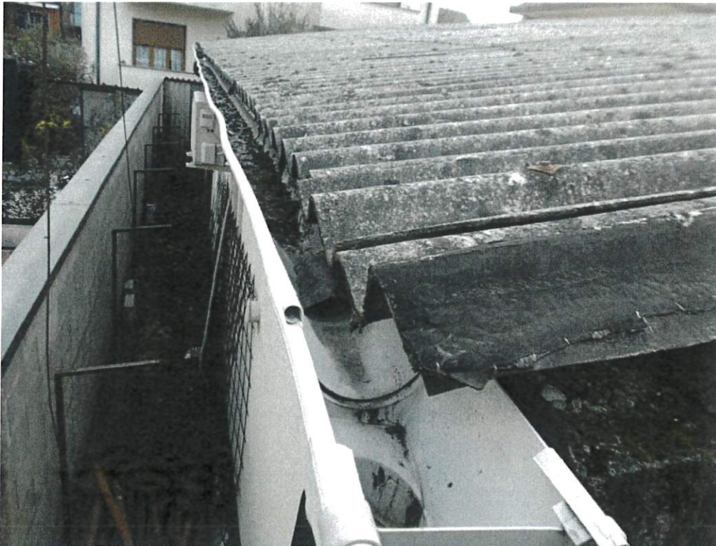
Foto 15: particolare del manto di copertura/canale di gronda - Fabbricato B
