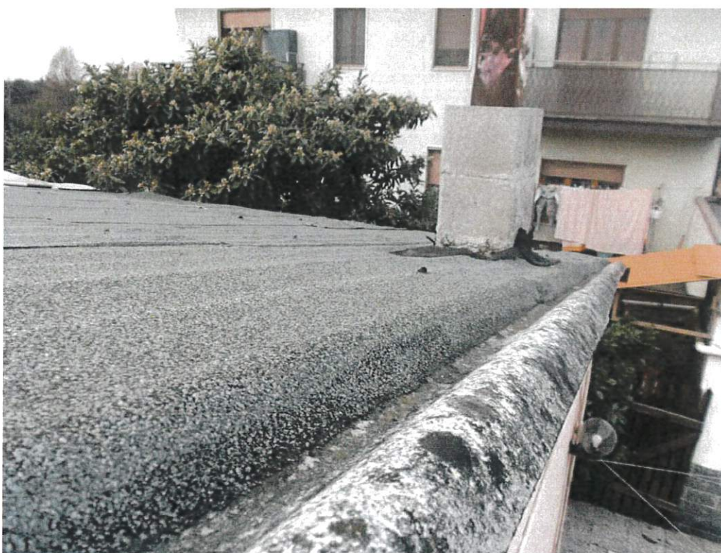
Foto 04: particolare del manto di copertura - Fabbricato A
