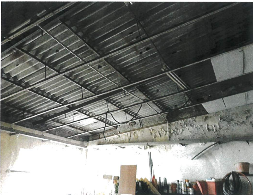
Foto 08: Manto di copertura interno - Fabbricato A
