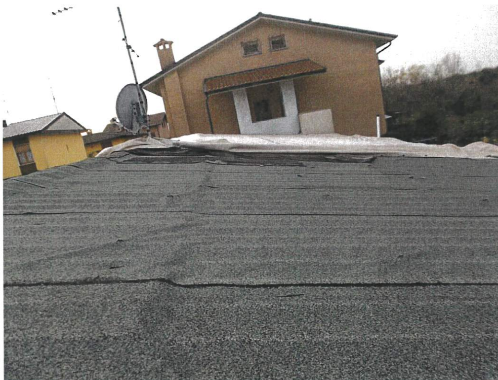
Foto 02: Manto di copertura esterno - Fabbricato A
