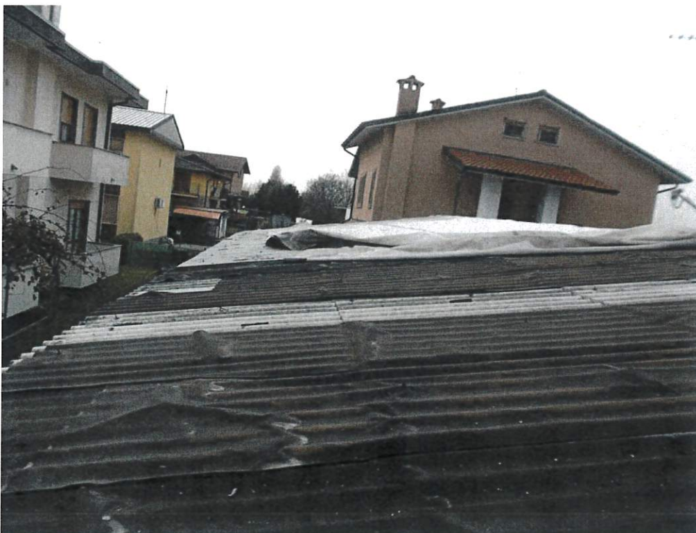
Foto 03: Manto di copertura esterno - Fabbricato A
