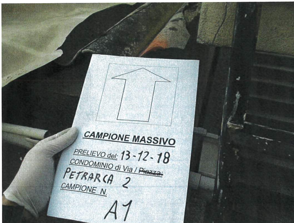
Foto 13: particolare del punto di prelievo del manto di copertura Fabbricato A
