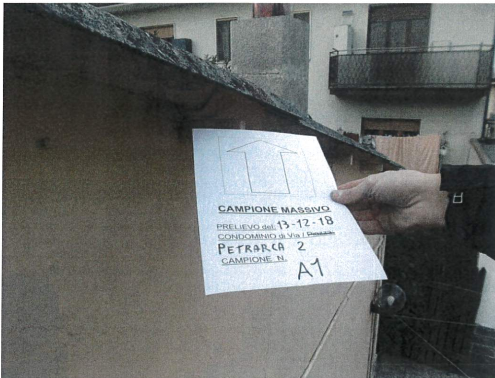
Foto 11: particolare del punto di prelievo del manto di copertura - Fabbricato A
