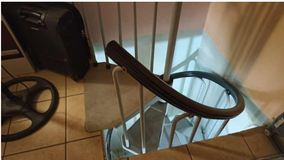
Foto n.8 – scala a choccia
