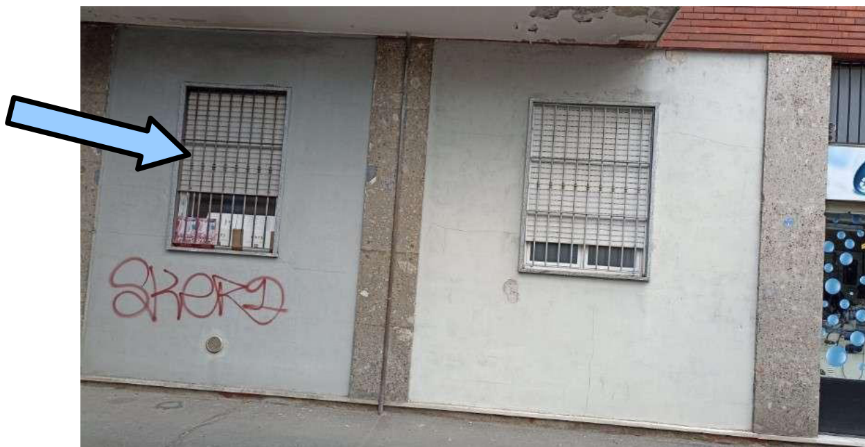
Foto n.13 – finestra lato via Trasimeno
