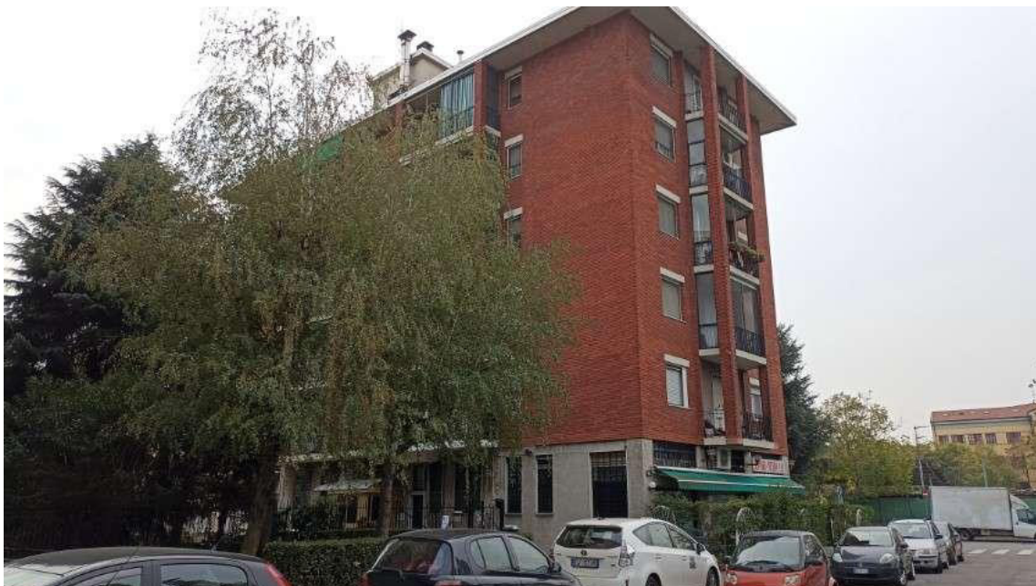
Foto n.1 – Condominio via Trasimento 18/2
