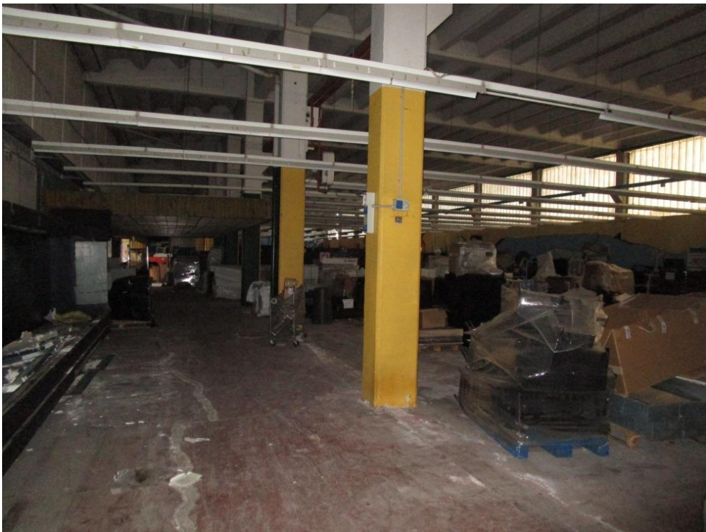
Foto 7 – Capannone attualmente ad uso commerciale
