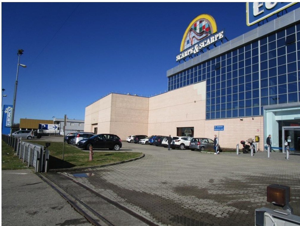
Foto 1 – Vista del centro commerciale (lato sud) da via Monza
