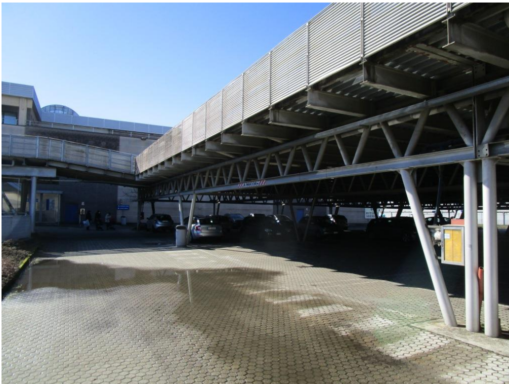
Foto 5 – Vista del Centro Commerciale (lato nord) in corrispondenza delle aree parcheggio al piano terra e sopraelevato
