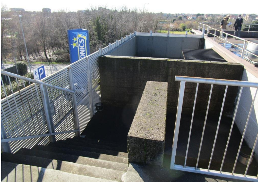
Foto 25 – Scala di emergenza (lato est)
