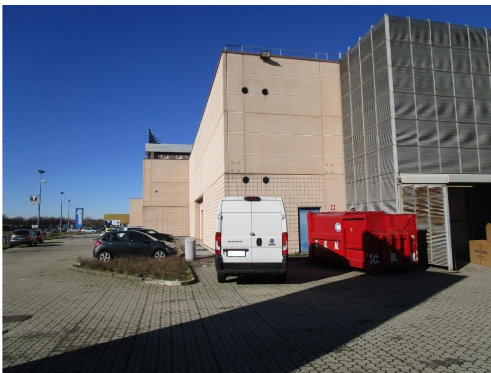
Foto 3 – Vista del Centro Commerciale (lato est) e relativa area esterna
