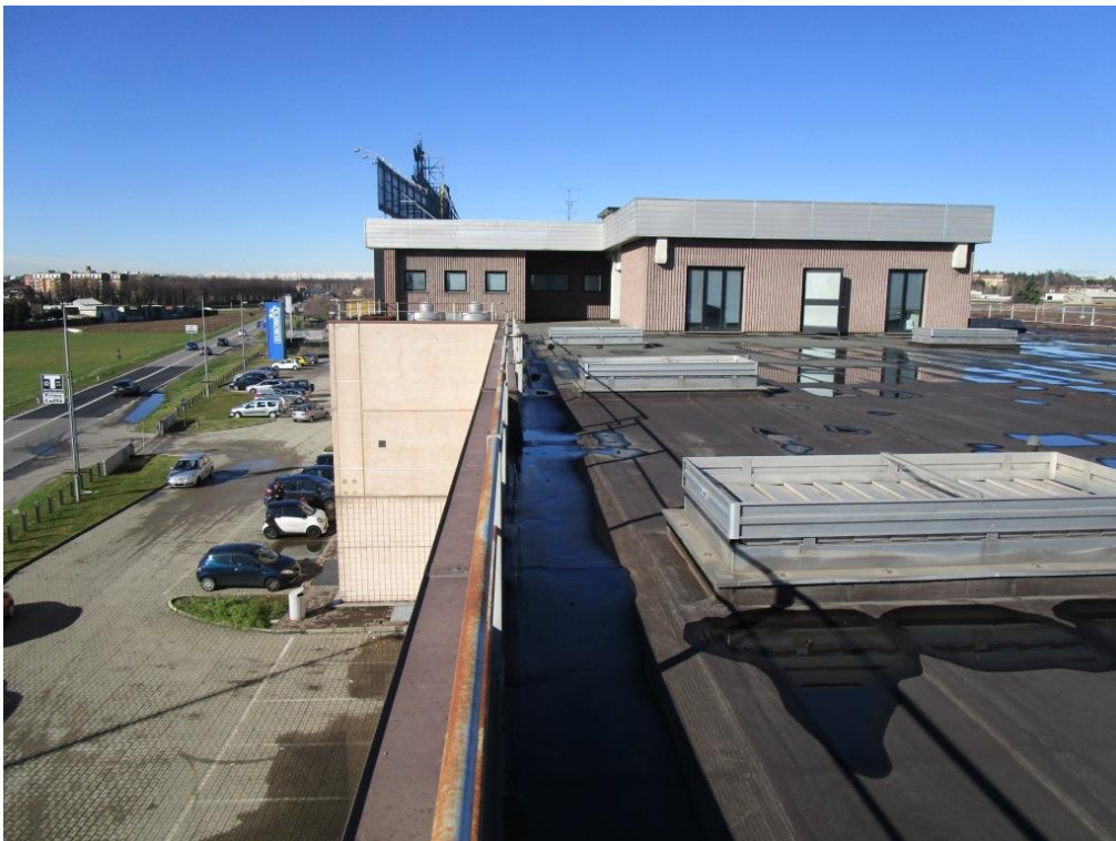
Foto 23 – Copertura – lastrico solare
