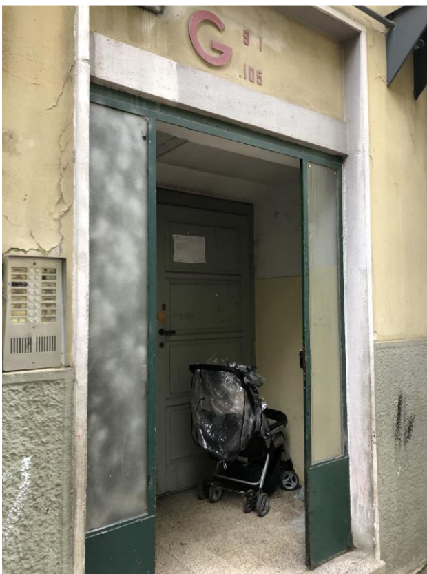
Vista porta di ingresso scala G
