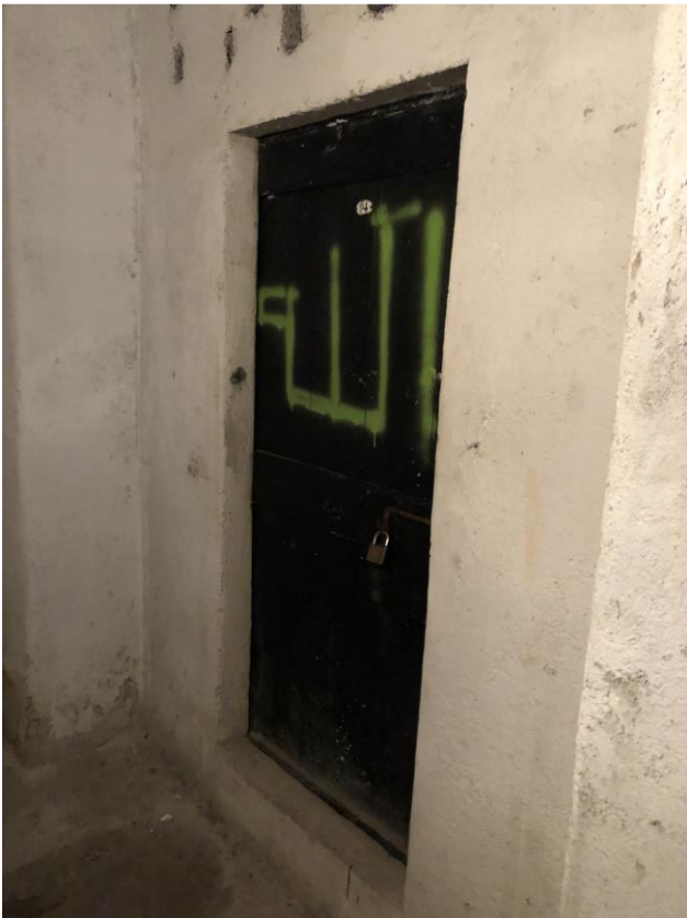
Vista porta cantina di pertinenza
