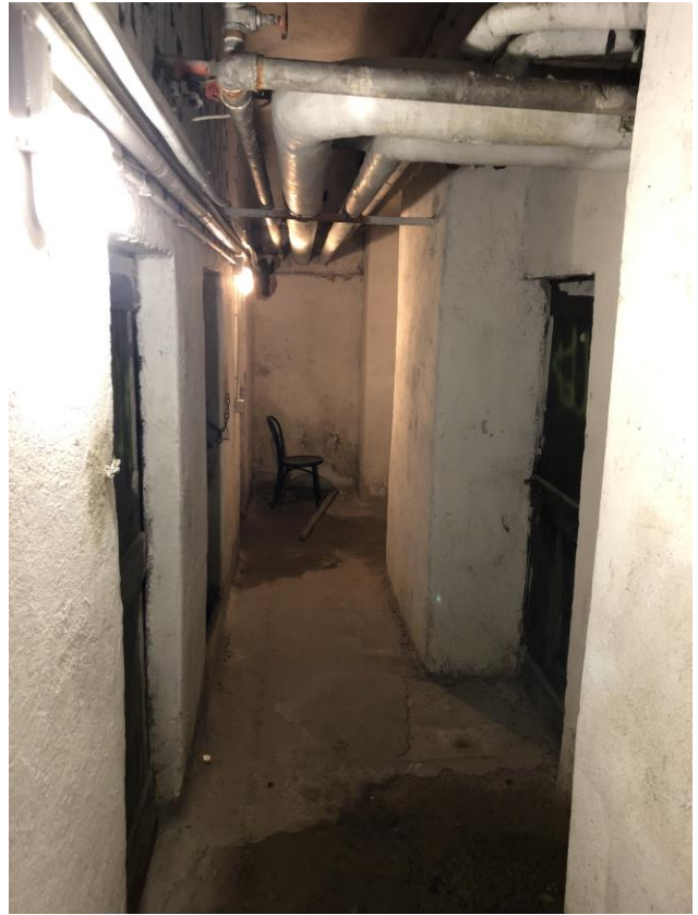
Vista corridoio comune cantine
