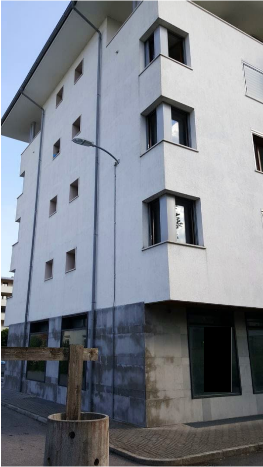
FIANCO DEL FABBRICATO
