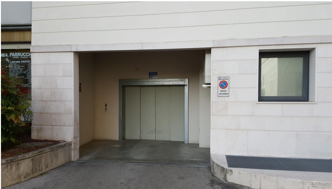
ACCESSO AL MONTACARICHI DA PIAZZA MANIN
