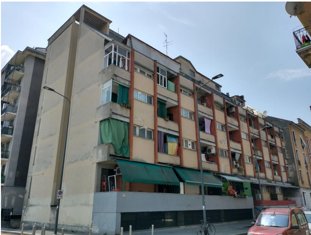
Foto 1 – Vista da via 8 Ottobre 2001, dello stabile in cui è ubicata l'unità immobiliare
