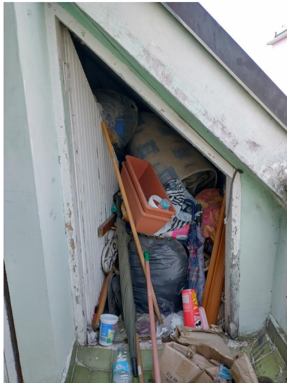
Foto 22 – Ripostiglio realizzato nel sottotetto con accesso dal balcone
