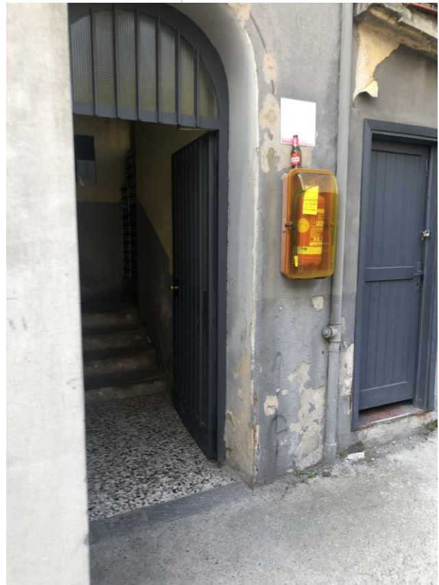
VISTA PORTONCINO ACCESSO AL FABBRICATO
