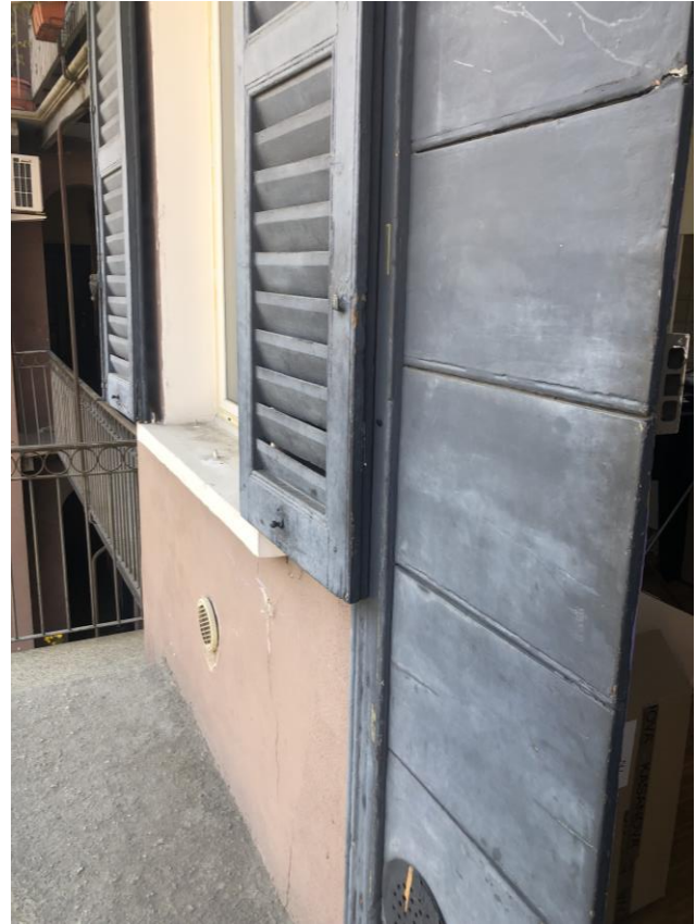
VISTA PORTA INGRESSO
