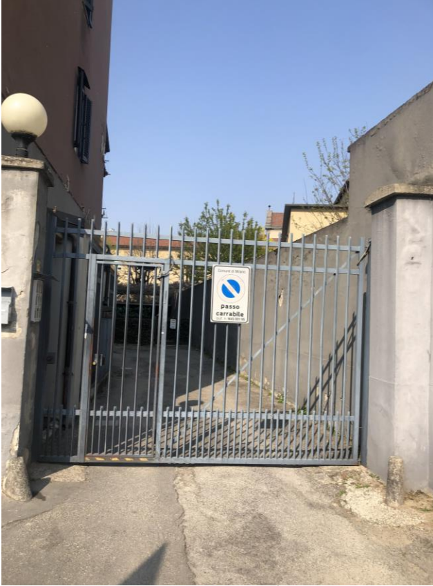
VISTA INGRESSO AL FABBRICATO DA VIA CINO DA PISTOIA N. 9
