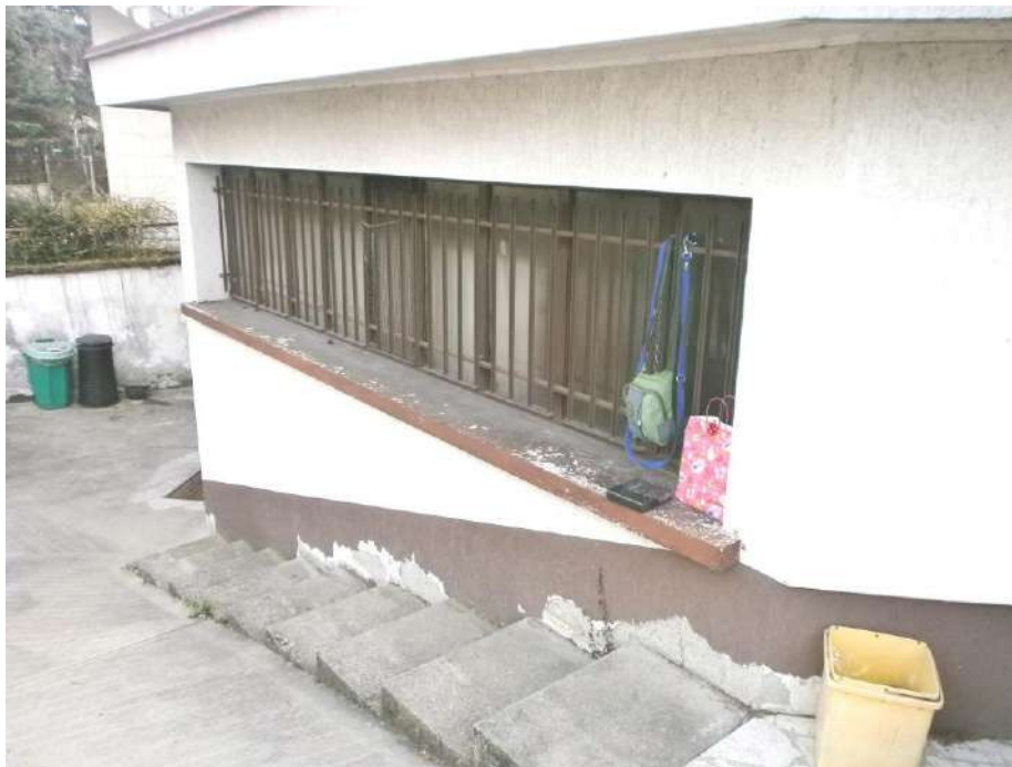
– FOTO 6 – FRONTE NORD - EST –
