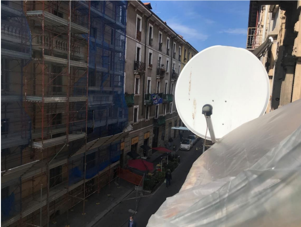
Foto n. 17: Affaccio dalla camera.
