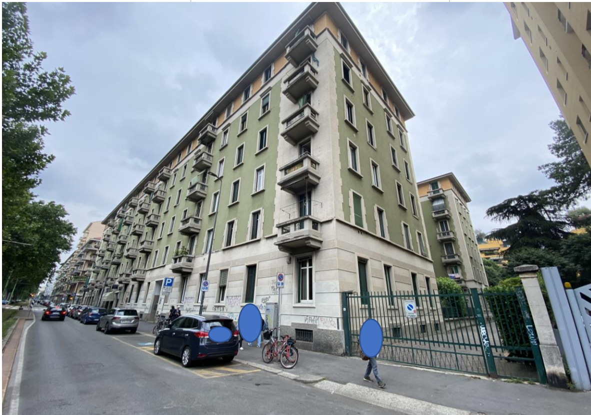
VISTA ESTERNA DEL COMPLESSO
