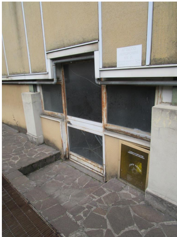
Foto 6 – Ingresso al magazzino
