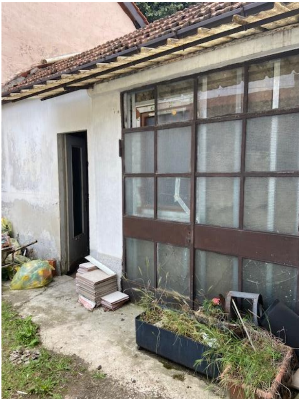
Vista esterna porzioni deposito/tettoia
