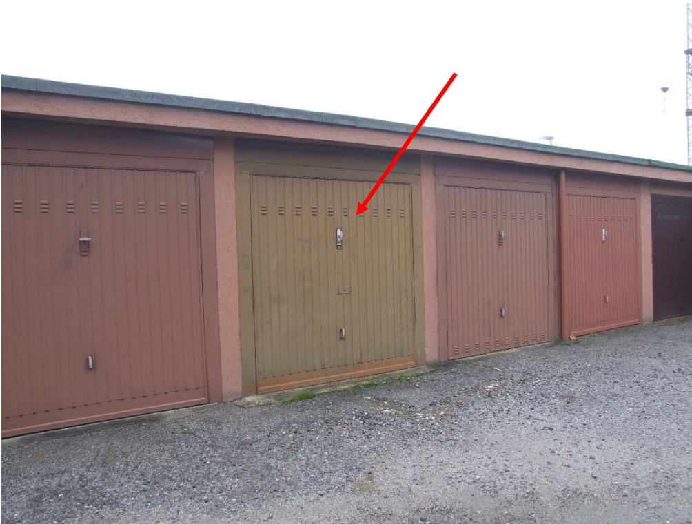
Foto 12: esterno box (il 14° da sinistra e il 4° da destra)
