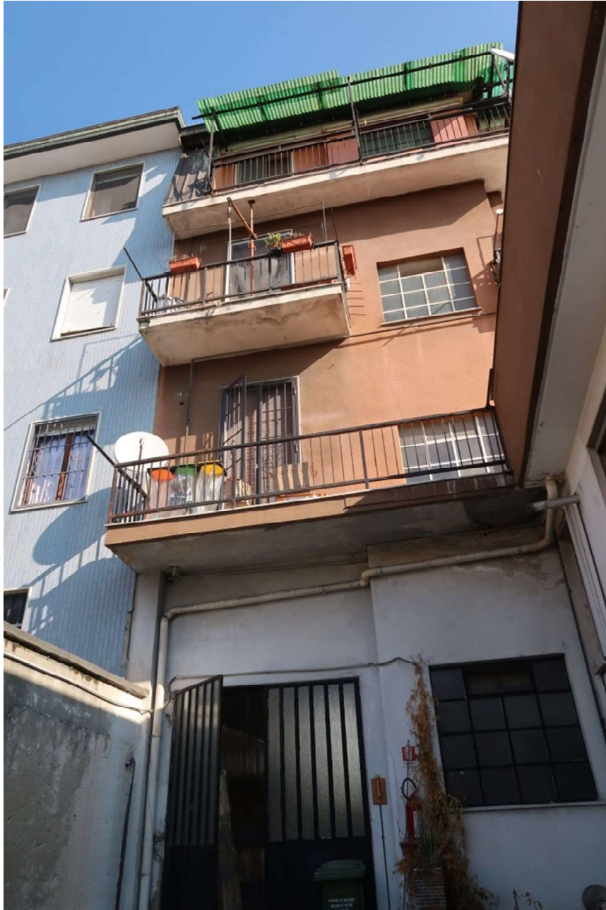
FACCIATA SU CORTILE INTERNO
