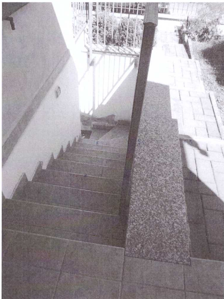
Foto 20: scala di accesso alla cantina
