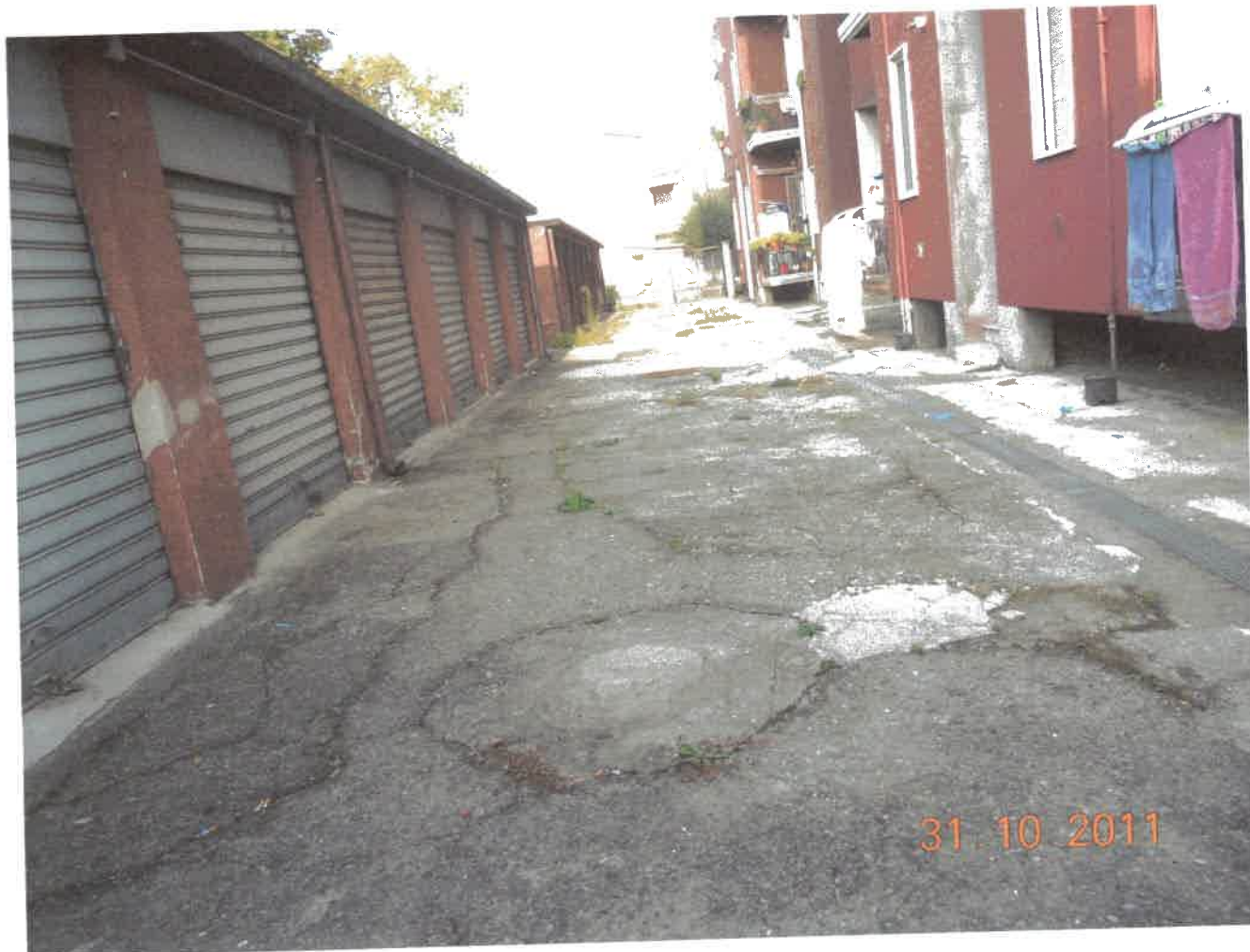
Vista del cortile interno.
