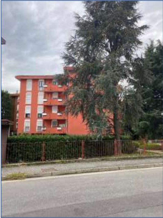
Foto 1 - immobile di via XXV Aprile n. 24
