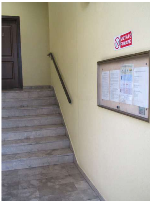
Ingresso dell'edificio al piano terra
