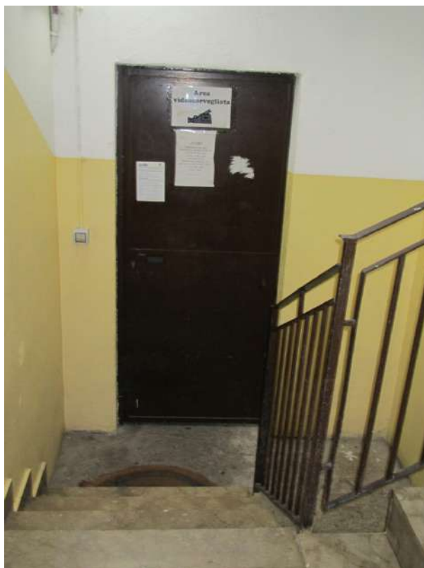
Porta di accesso alle cantine condominiali
