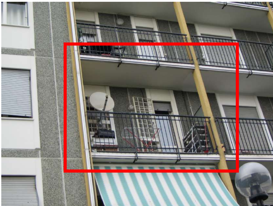
Balcone dell'unità immobiliare oggetto di Procedura Esecutiva
