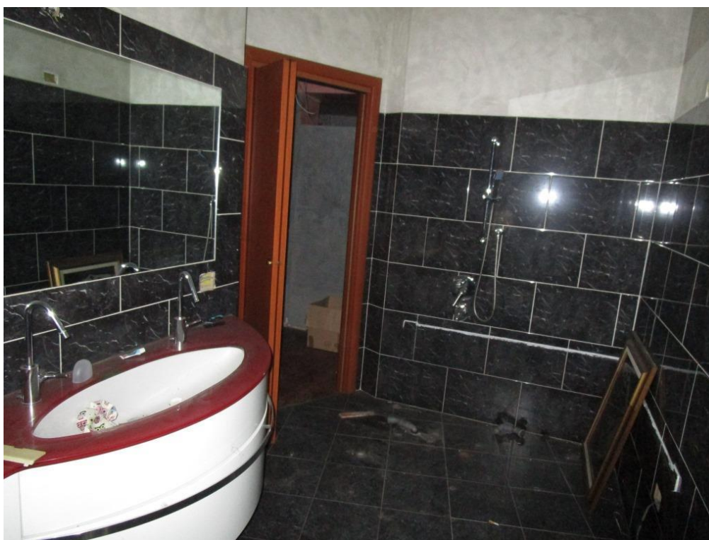
Foto 14 – Vista del servizio igienico verso il soggiorno
