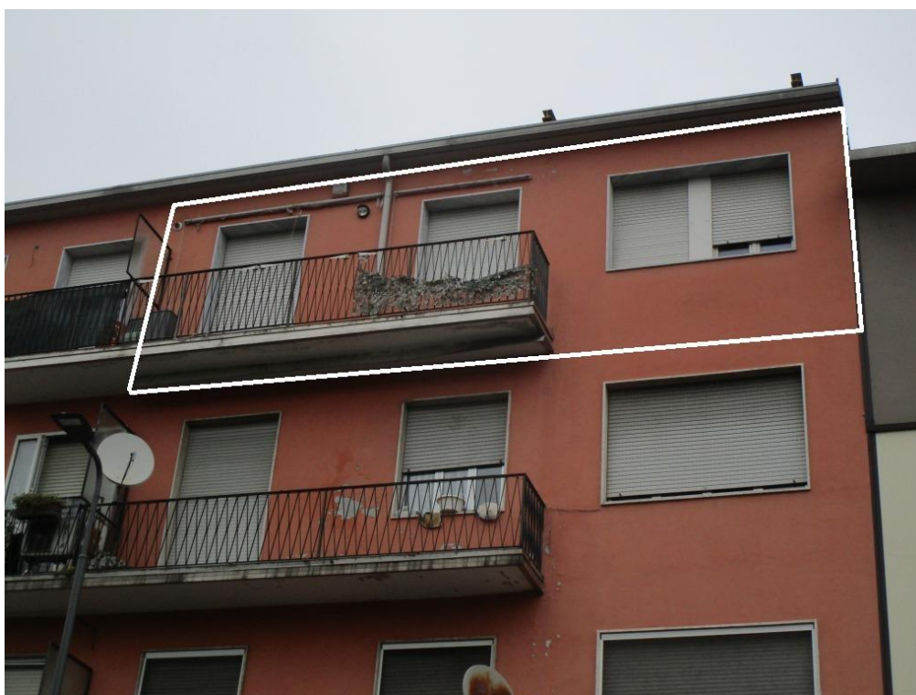
Foto 2 – Inquadramento da via Cassinis dell'unità immobiliare
