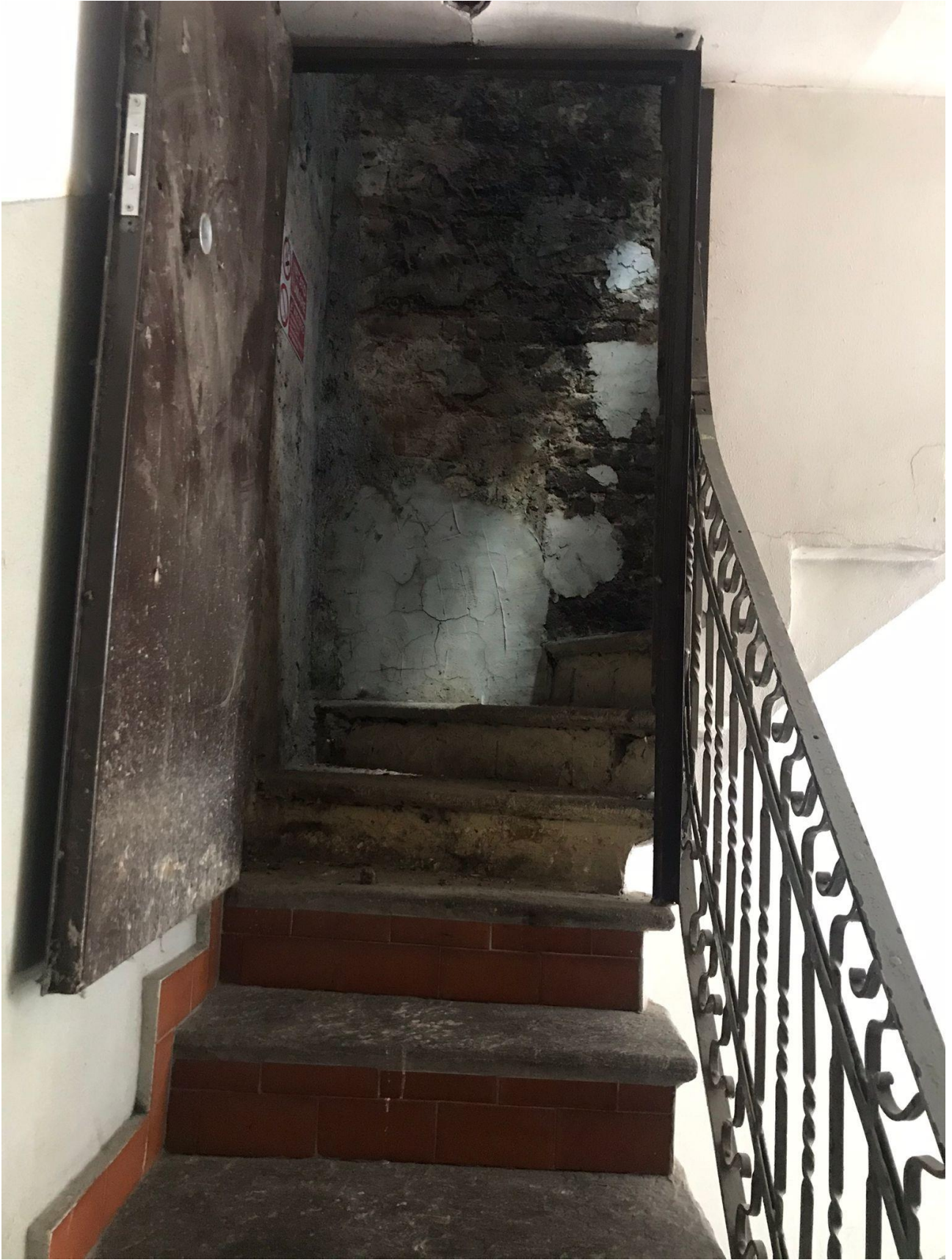
Scale accesso solaio Condominiale
