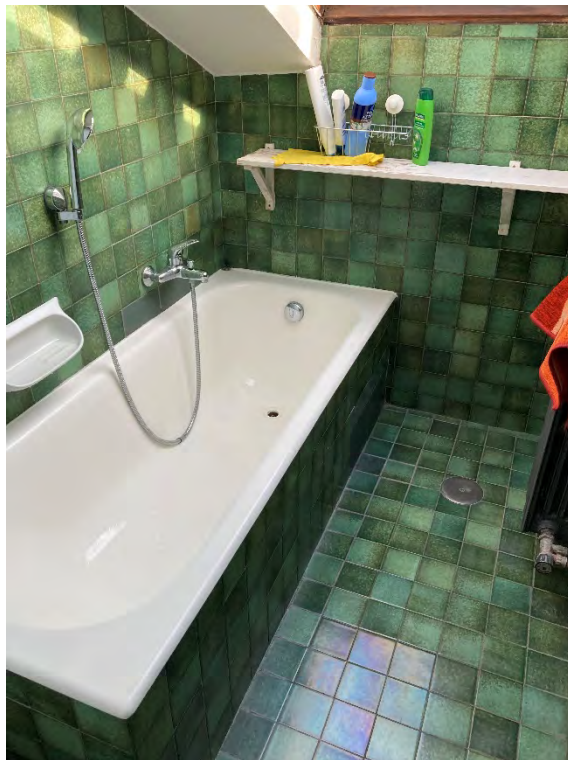
Foto n. 17: Servizio al piano quinto.
