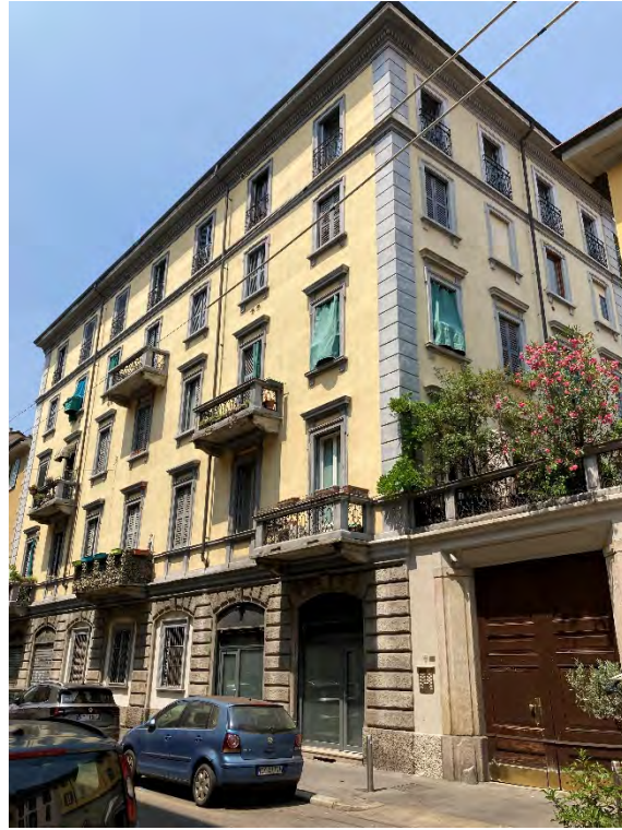
Foto n. 1: Prospetto principale su Via Paolo Frisi.
