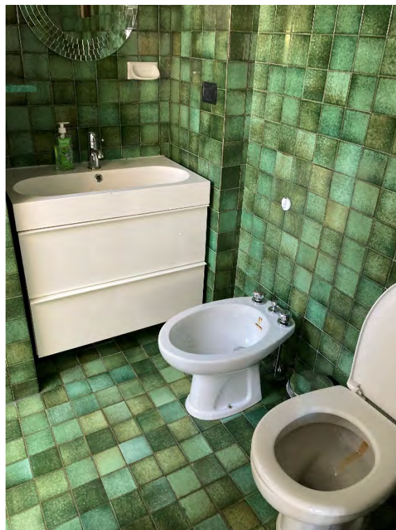
Foto n. 16: Servizio al piano quinto.
