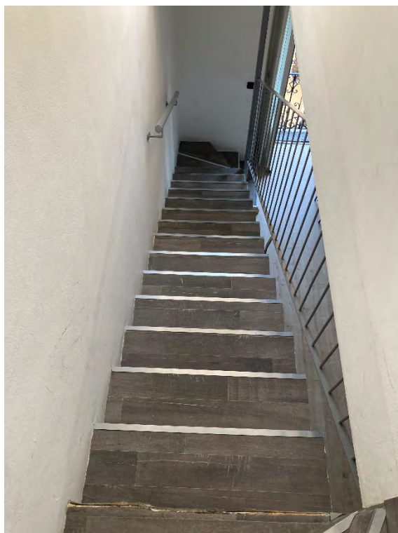
Foto n. 10: Scala di collegamento con il piano quinto.
