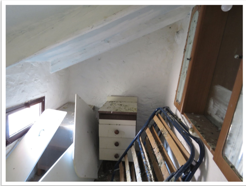
Viste del ripostiglio.
