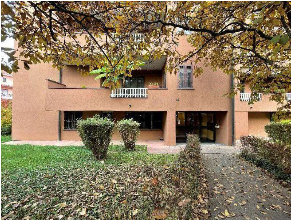
FOTO 1: MELZO, VIA M. ZANUTEL 2, ingresso condominiale-scala A
