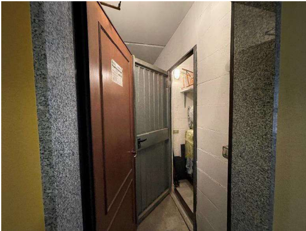
FOTO 15: MELZO, VIA M. ZANUTEL 2, accesso alla cantina
