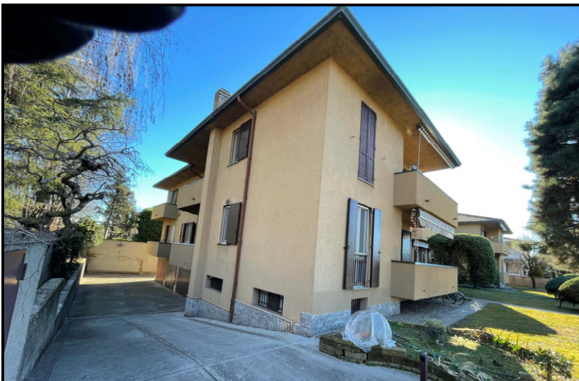
Vista da ingresso corsello box
