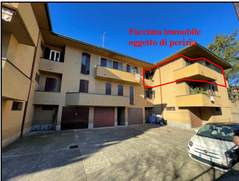
Vista da corso box condominiale
