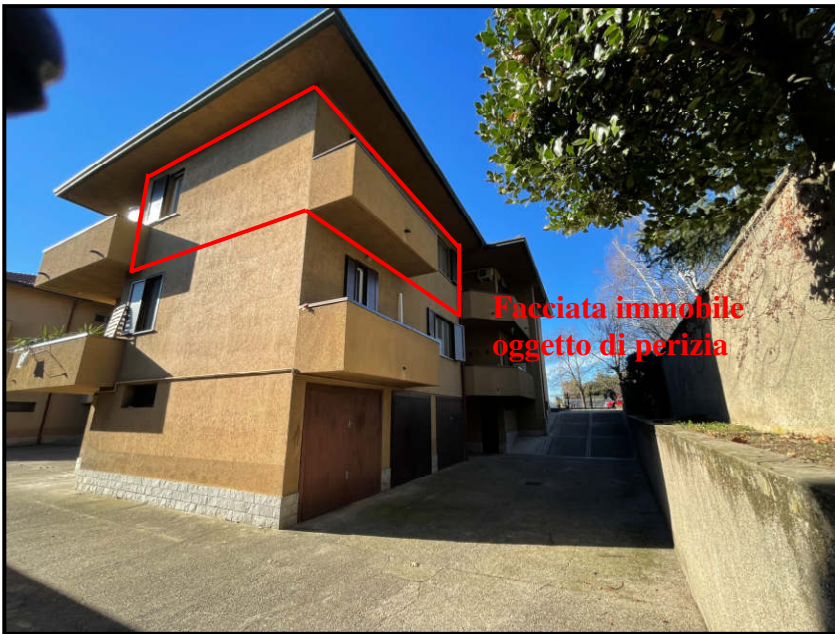
Vista da corso box condominiale
