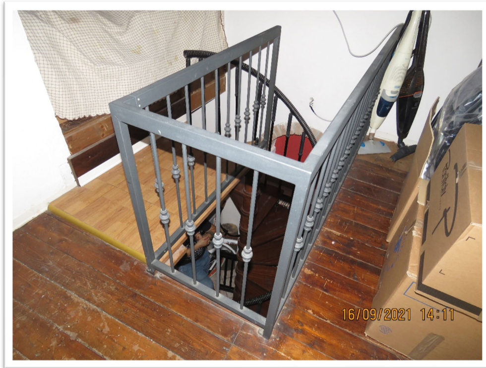
Il solaio sottotetto (senza permanenza di persone).
