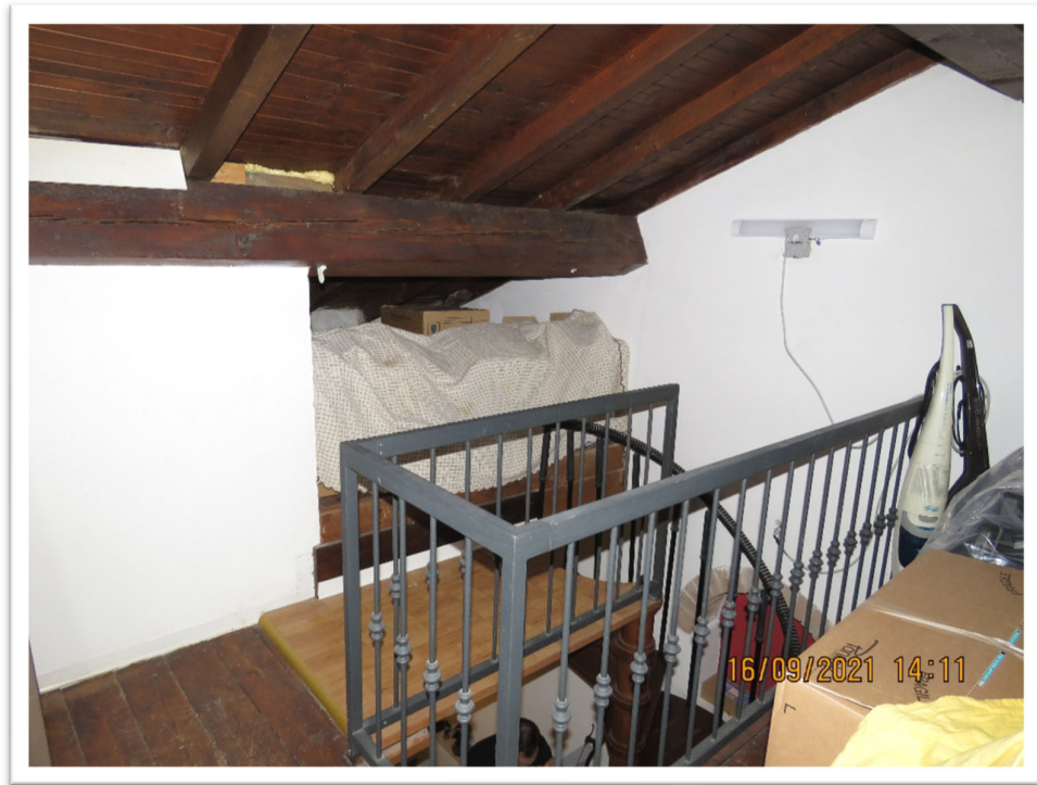
Altre viste del solaio sottotetto (senza permanenza di persone).
