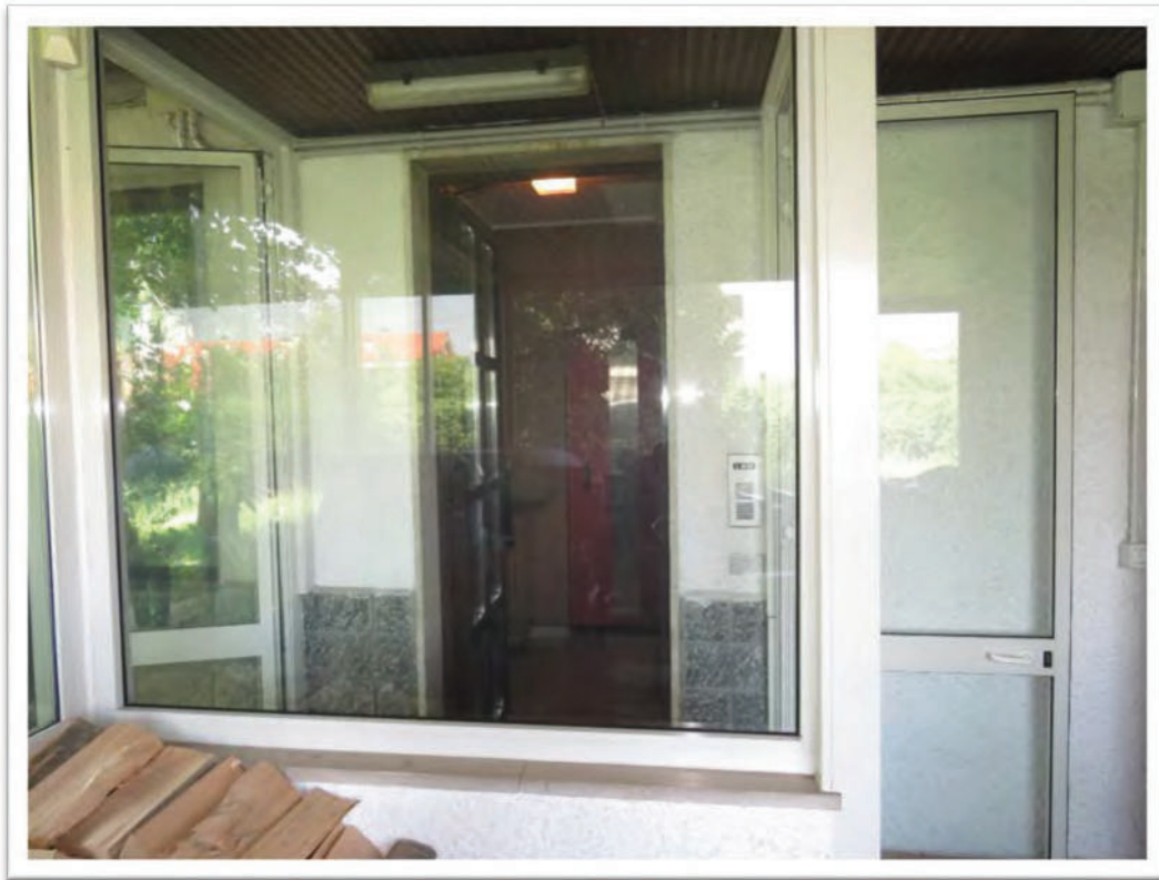
L'ingresso al vano scale che conduce all'abitazione del custode al piano primo.
