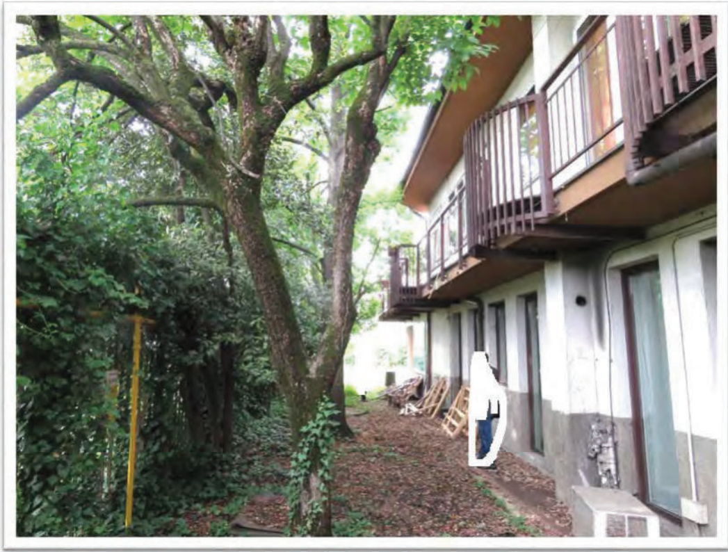
L'area esterna posta verso il confine Ovest.
