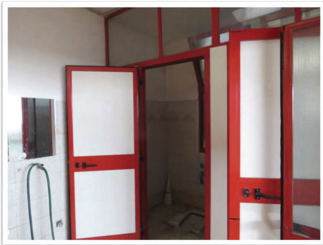
Servizi igienici del capannone.
