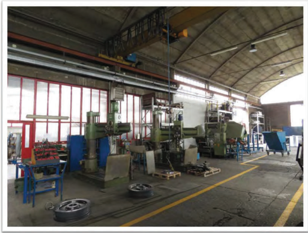
Interni del capannone.
