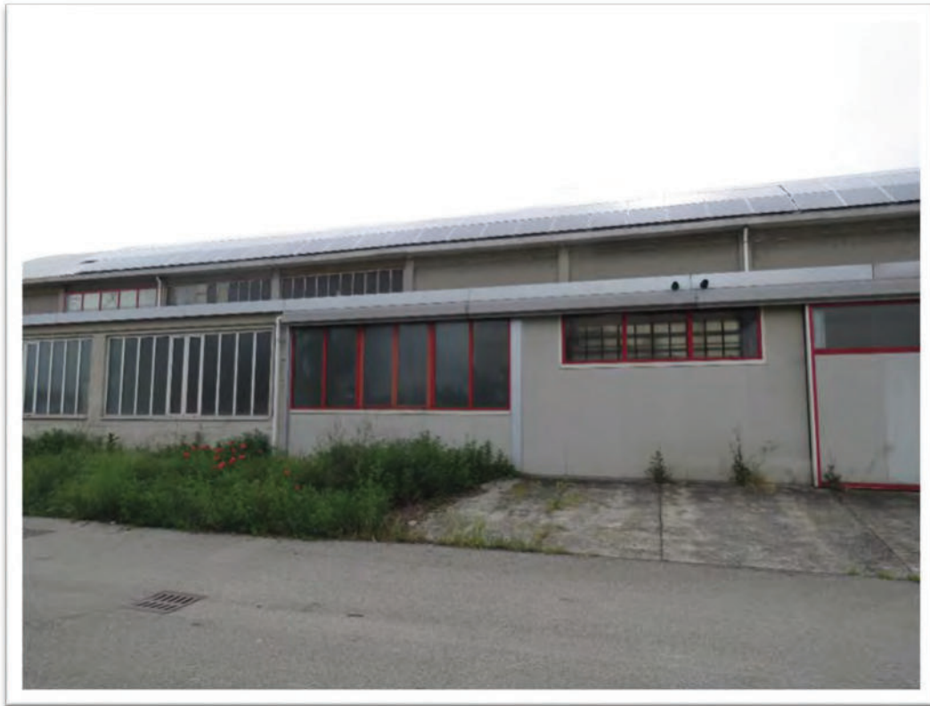
Vista del capannone ed annessi da via Bologna. Da notare i pannelli solari posti sulla copertura .
