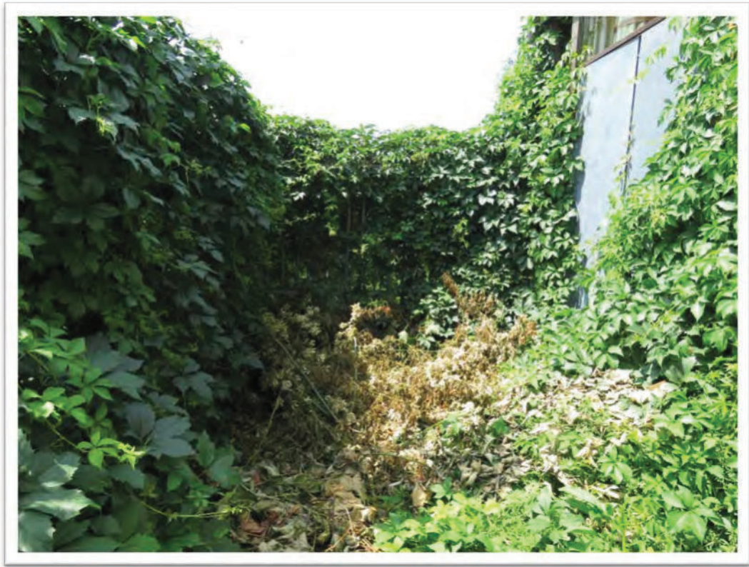
Area esterna / confine Sud-Ovest e tettoia di cui non è stato reperito il titolo edilizio.
