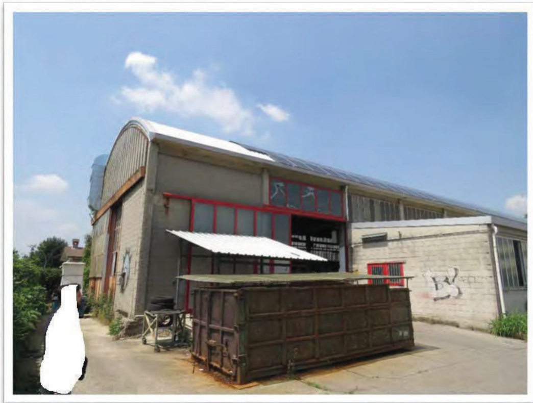
Estremità Sud del capannone ed annessi. Da notare i pannelli solari posti sulla copertura .
