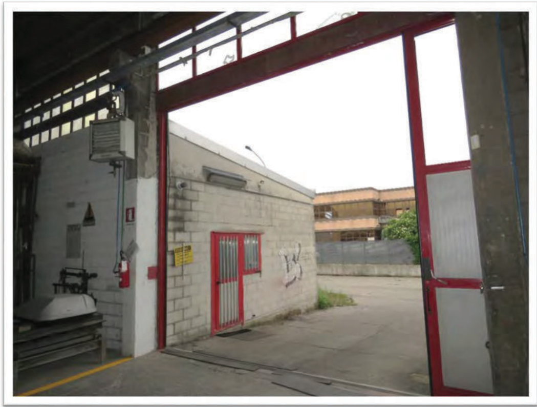
Ingresso principale al capannone.
