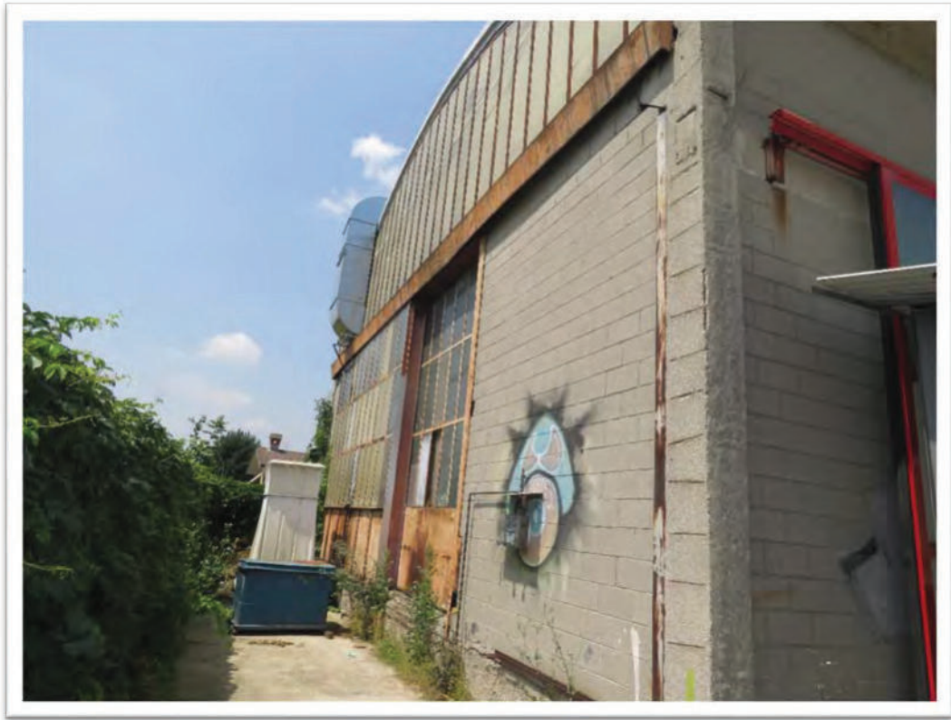
Testata Sud del capannone.
