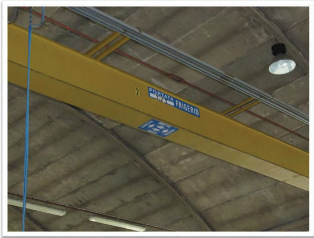
Interni del capannone.
