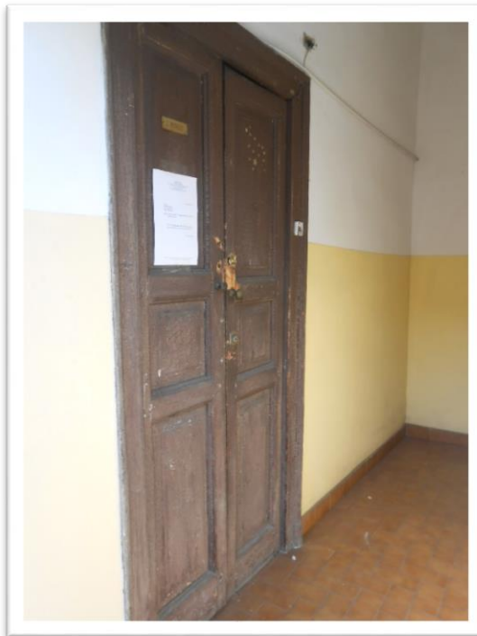
Foto 9 porta ingresso all'immobile
