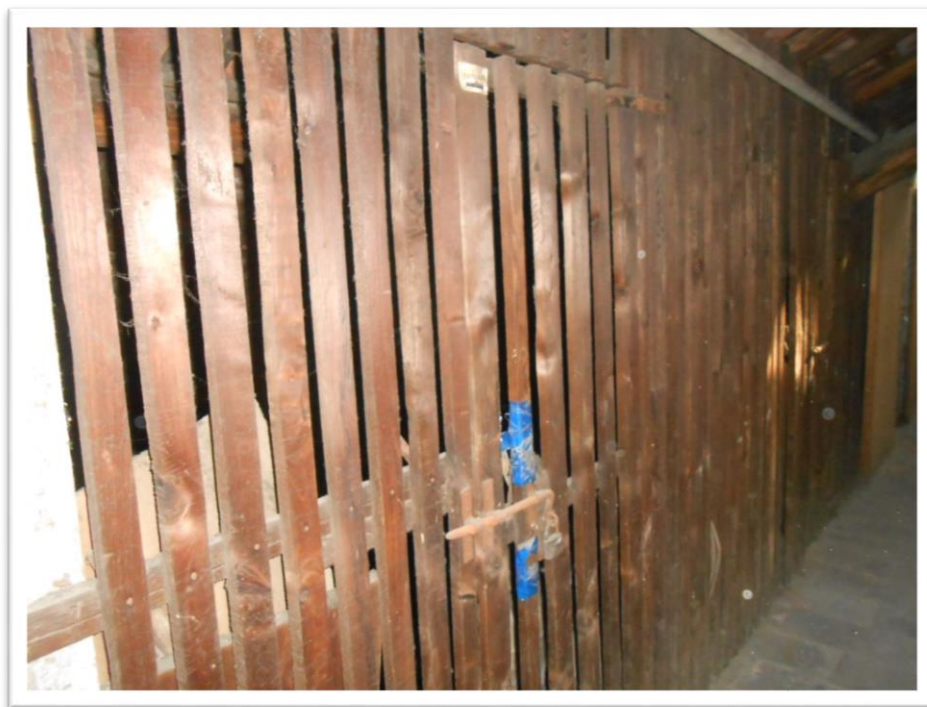
Foto 19 porta ingresso solaio
