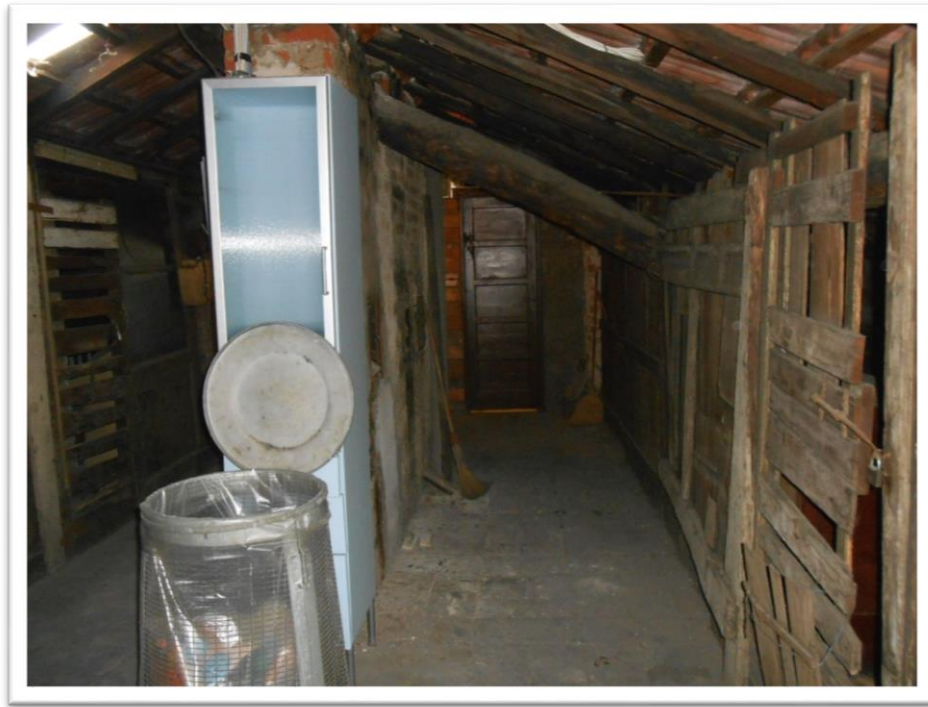
Foto 18 parti comuni solai
