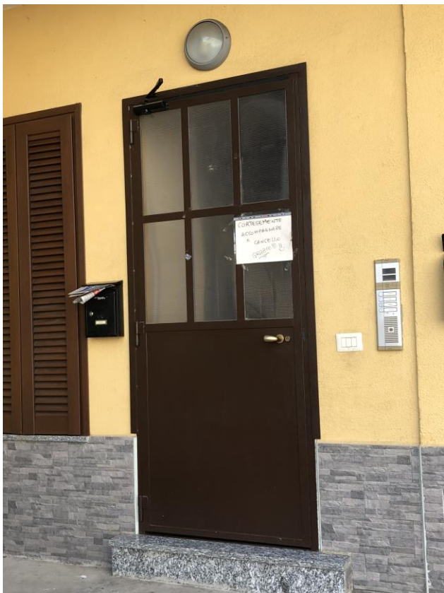
Vista porta di ingresso allo stabile
