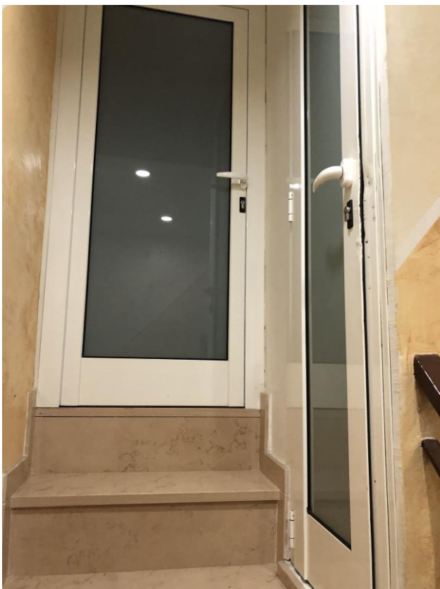
Viste porte rip. e solaio
