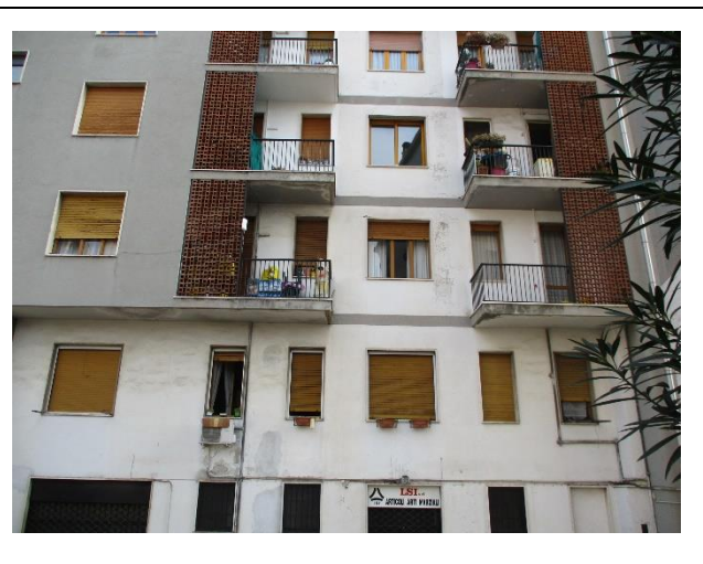
fabbricato- facciata interna
