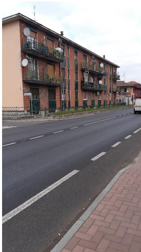
Via Cerca, 12 – fronte su strada
