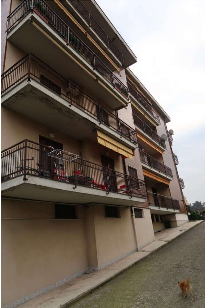
FACCIATA SU ACCESSO CARRAIO
