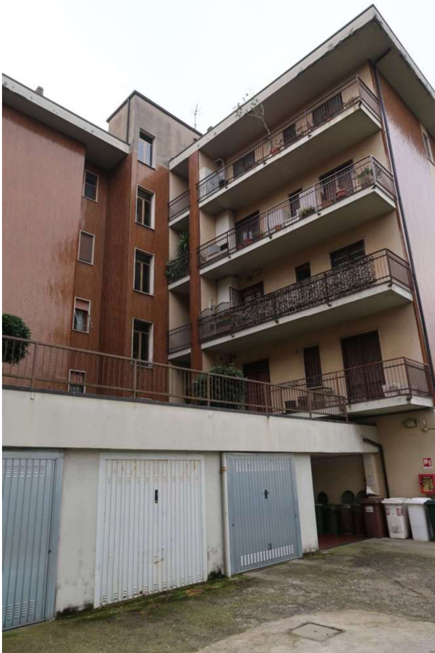
FACCIATA SU CORTILE INTERNO
