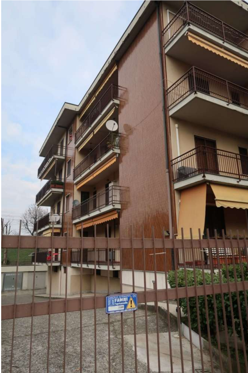
FACCIATA CON INGRESSO CARRAIO
