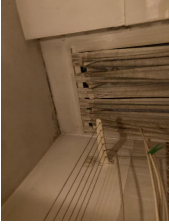
Bagno muffa a plafone in corrispondenza finestra
