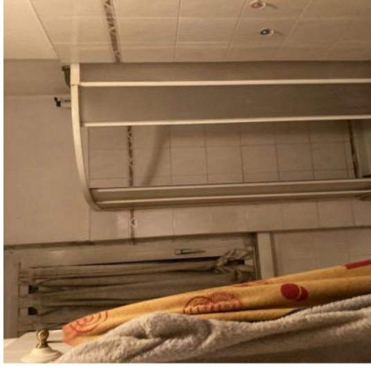
Bagno muffa a plafone in corrispondenza finestra
