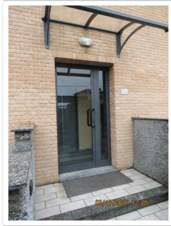
L'ingresso al vano scala B.
