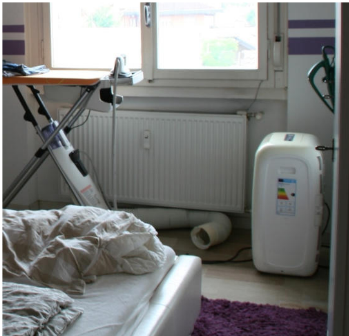
Termosifoni - elemento condizionatore.
