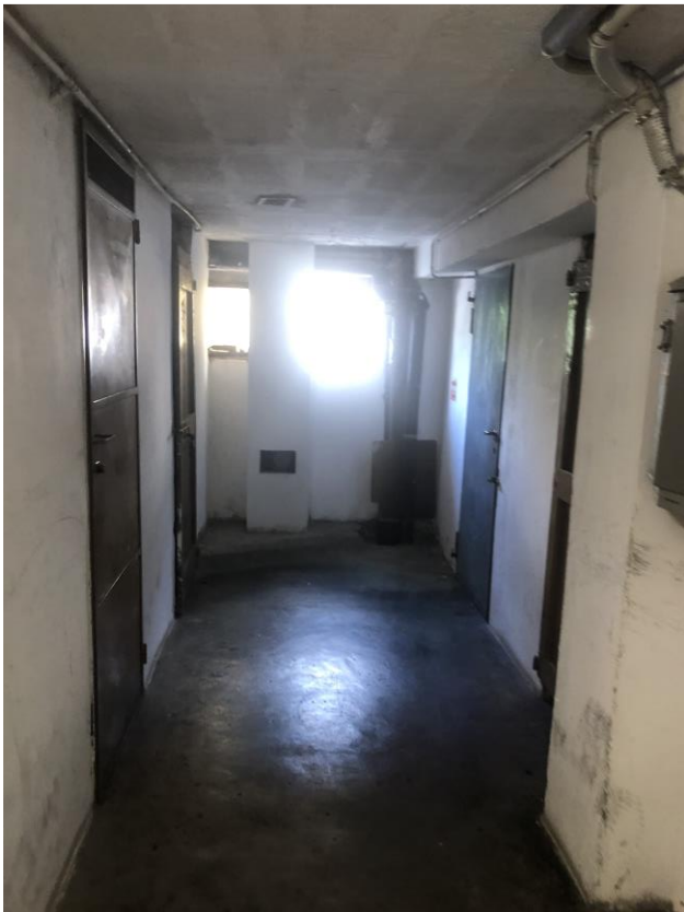
Vista spazi comuni cantine
