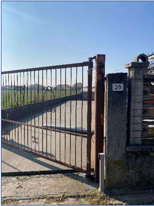
Foto 7 - accesso comune ai box - via Matteotti 28
