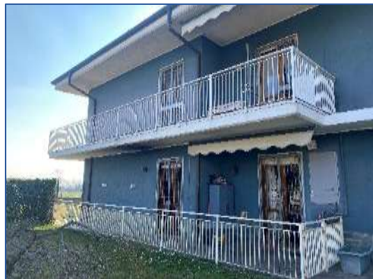
Foto 2 - immobile di via Matteotti n. 26
