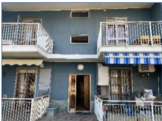
Foto 3 - immobile di via Matteotti n. 26
