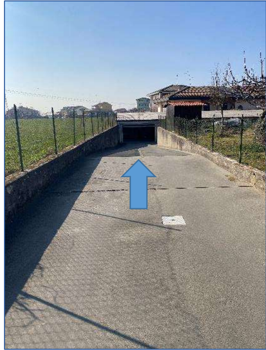
Foto 38 - accesso al box
