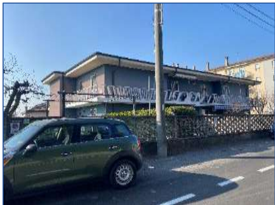
Foto 1 - immobile di via Matteotti n. 26
