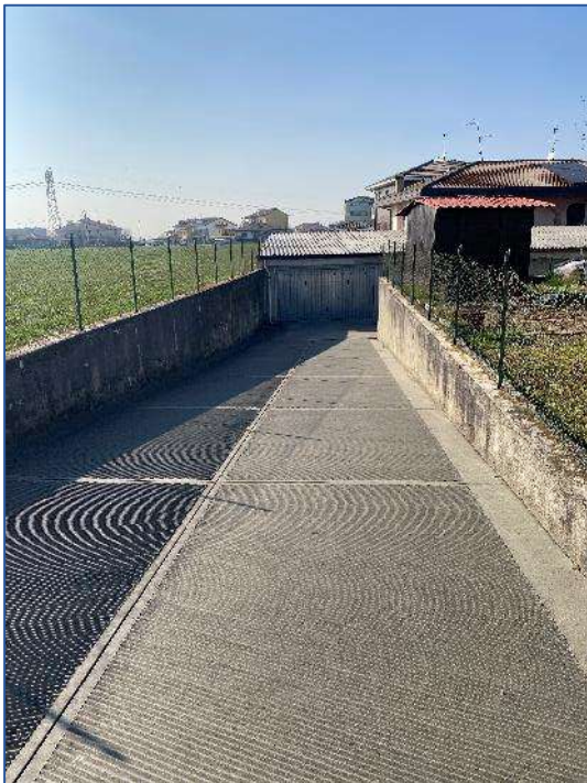
Foto 9 - rampa comune accesso box
