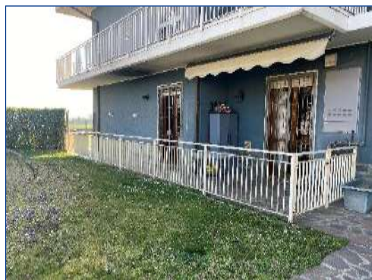
Foto 4 - immobile di via Matteotti n. 26
