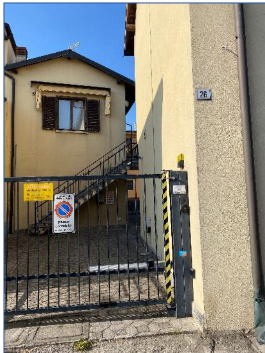
Foto 2 – ingresso via Milano n. 26
