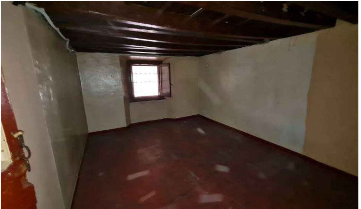
Deposito piano ammezzato
