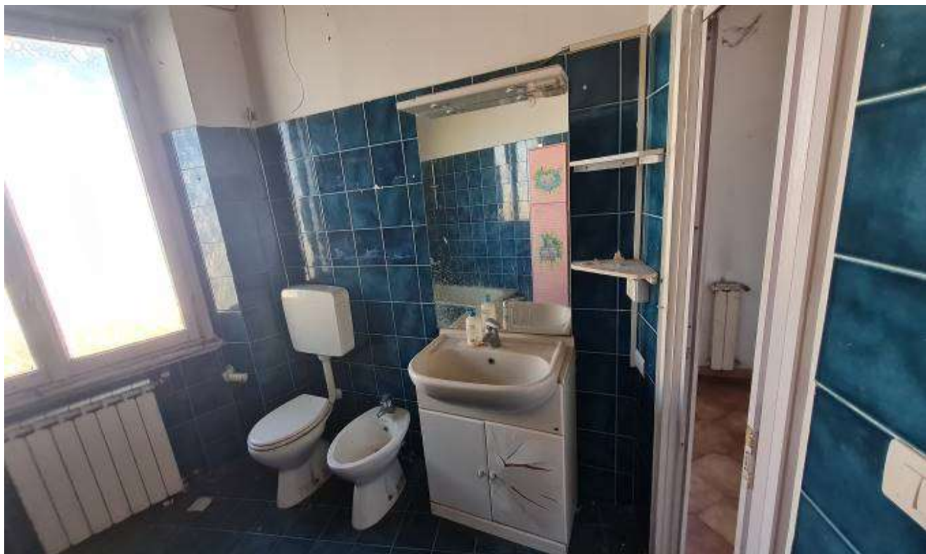
Bagno piano primo
