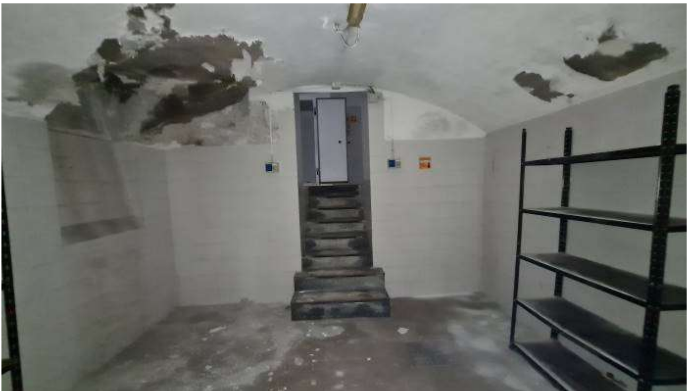
Cantina piano interrato
