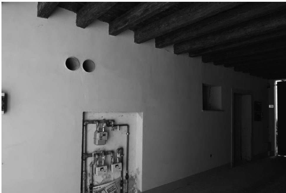
4. foto: vista lato androne interno.
