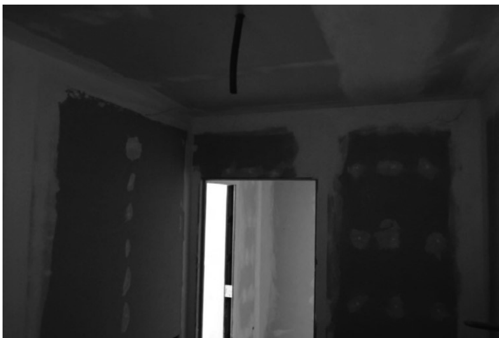
6. foto: finiture interne (corso di ristrutturazione)
