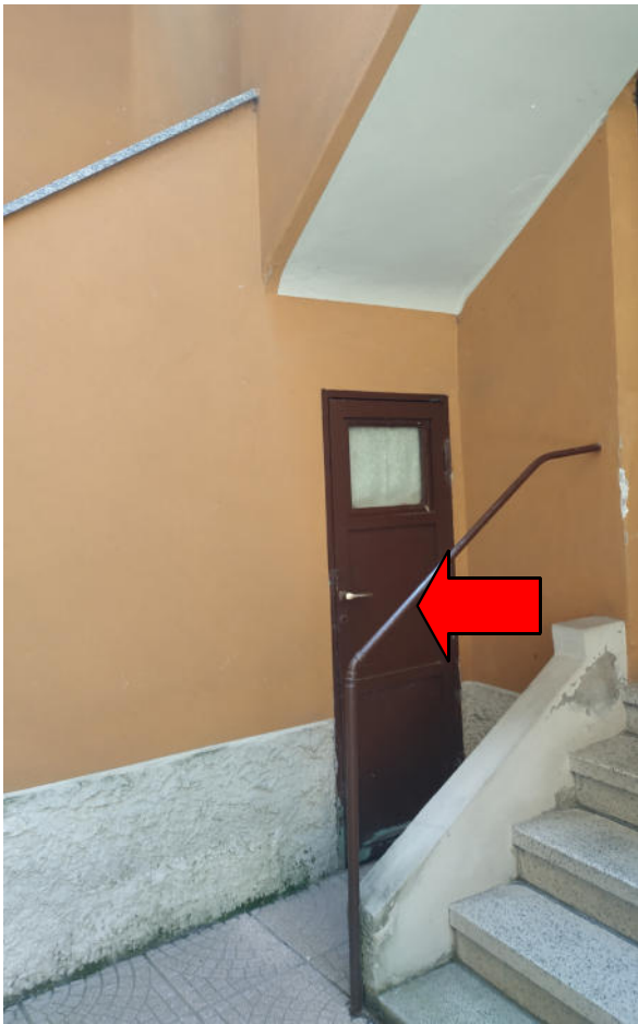
Ingresso bagno esterno
