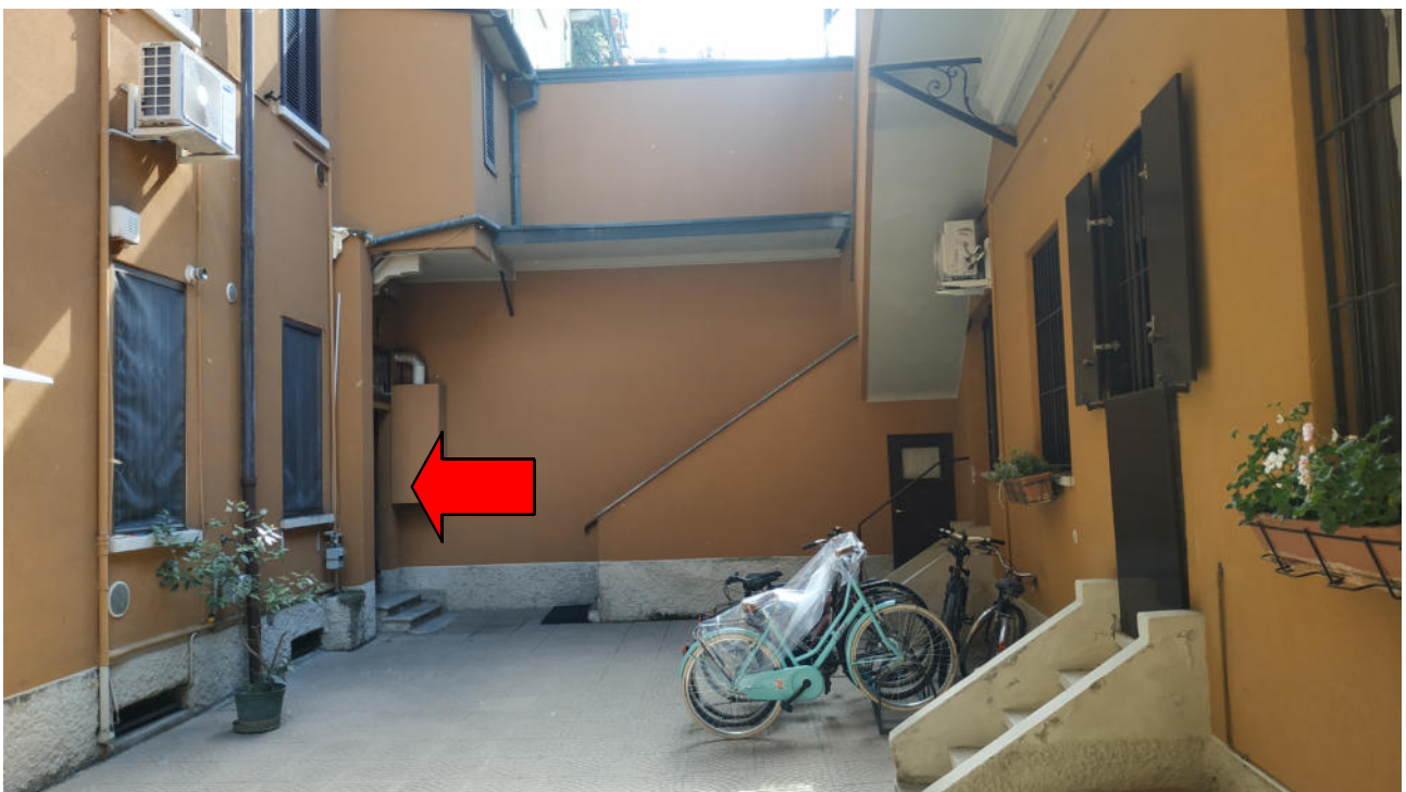
Cortile interno e ingresso all'immobile staggito
