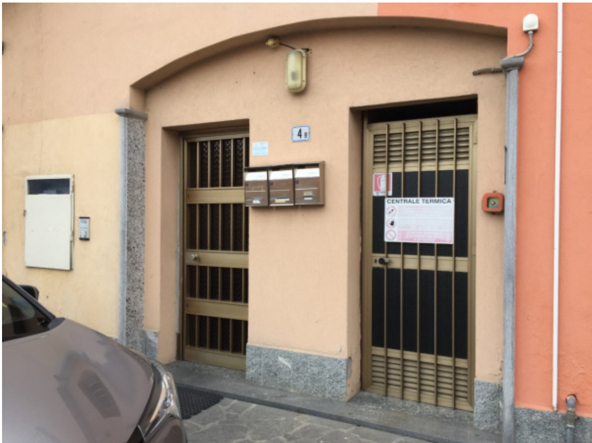
Foto 06 - Ingresso al fabbricato su Strada Nuova Pallese al civico 4/B
