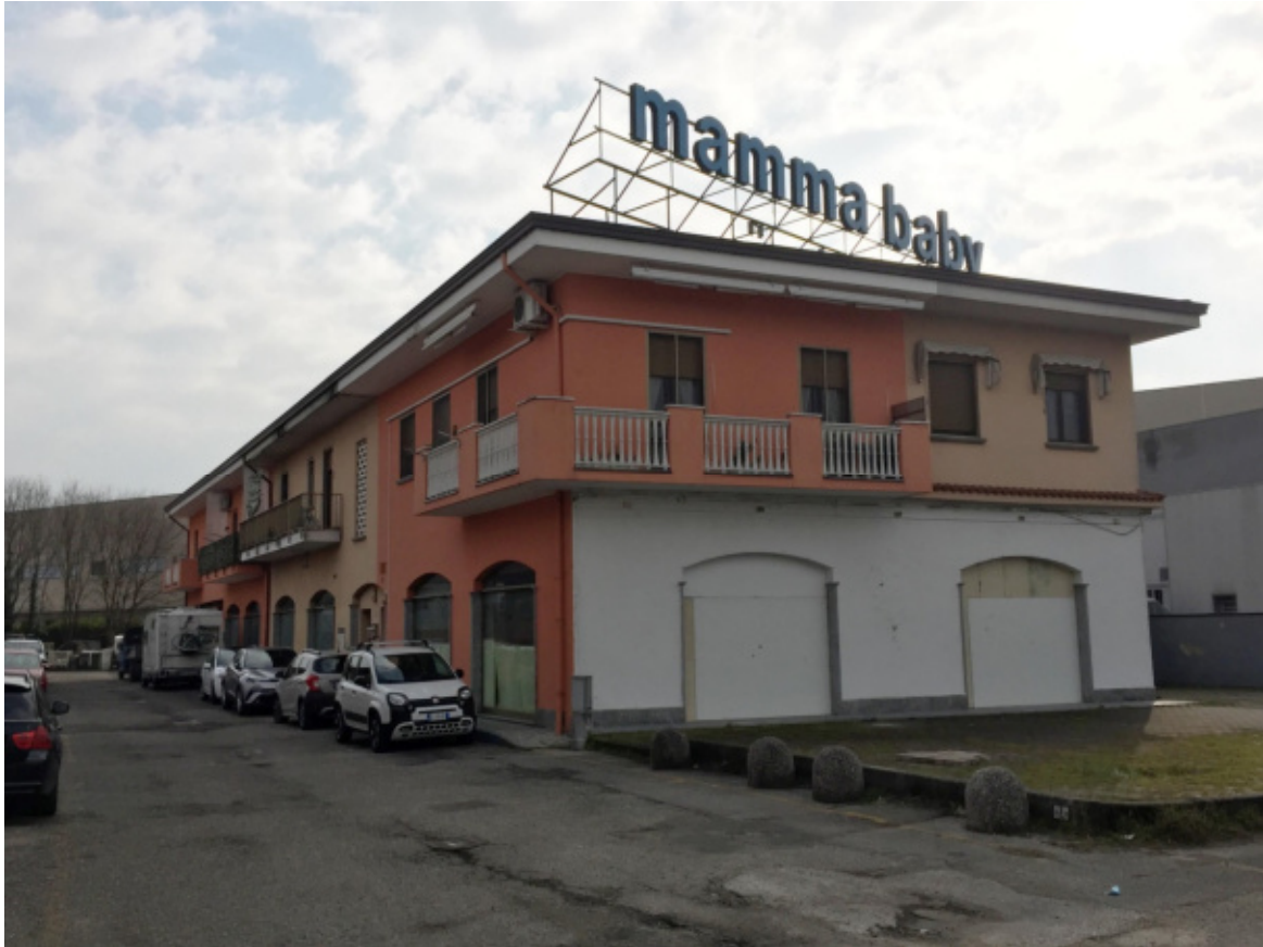
Foto 01 - Il fabbricato su Strada Nuova Puallese
