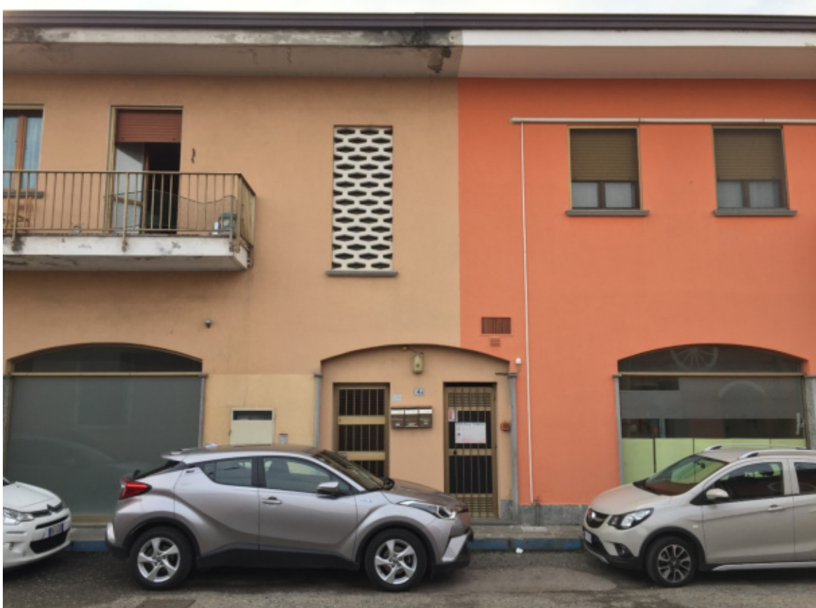
Foto 05 - Facciata del fabbricato su Strada Nuova Pallese al civico 4/B
