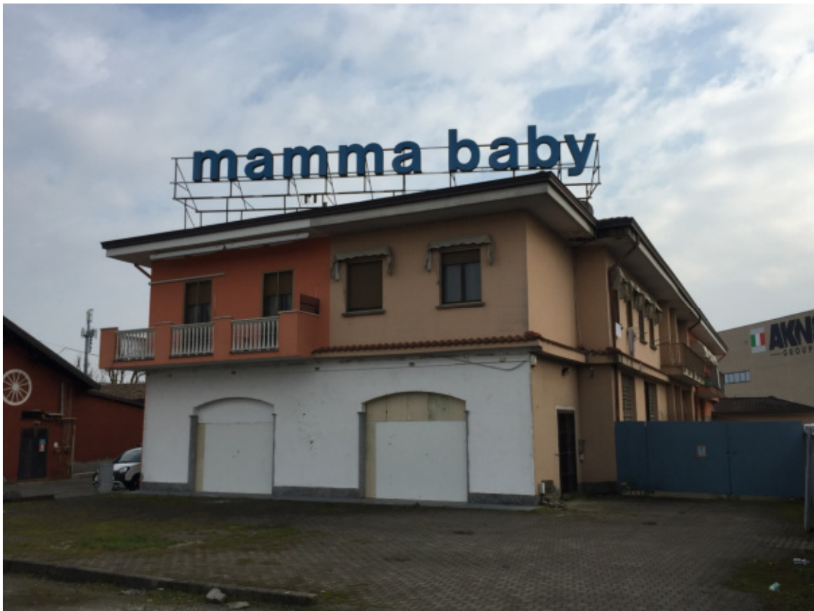
Foto 02 - Il fabbricato su Strada Nuova Puallese
